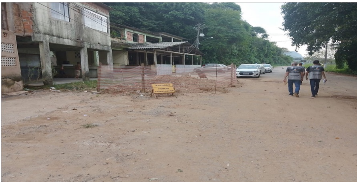
Foto 3 – Local onde será instalado o filtro para retenção de sólidos
