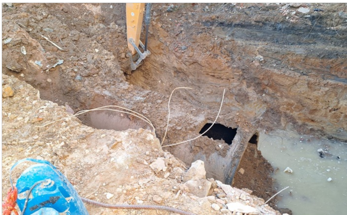
Foto 9 - Trabalhos de escavação do solo ao redor da tubulação em andamento.
