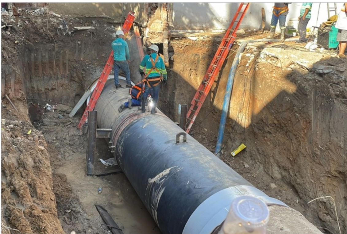
Foto 12 - Finalização do reparo da adutora com a solda da janela.
