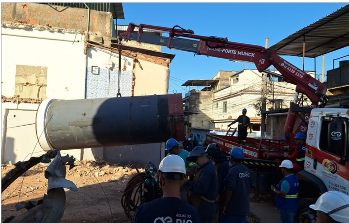
Foto 10 - Tubo telescopado utilizado em substituição a tubulação antiga.
