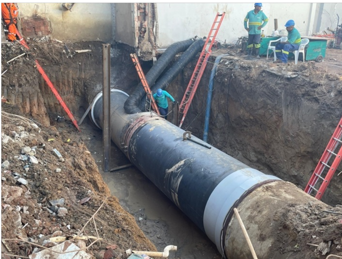
Foto 11 - Realização dos trabalhos de soldagem e impermeabilização interna da nova tubulação.
