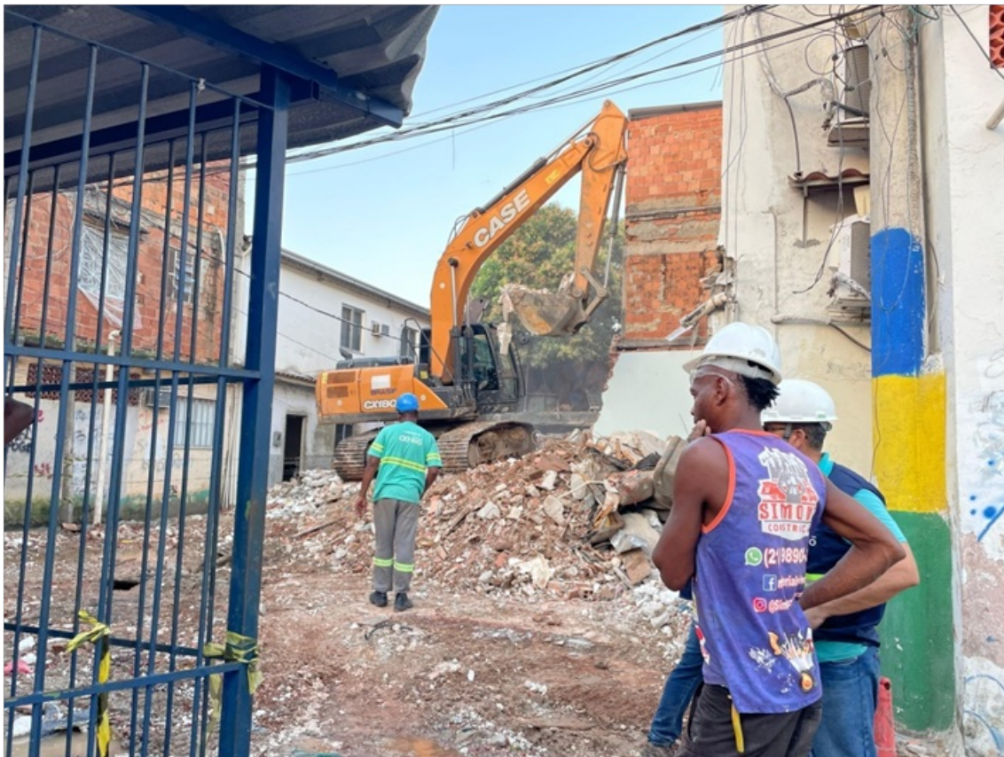
Foto 5 - Trabalhos de demolição sendo realizados pela Prefeitura do Rio de Janeiro.
