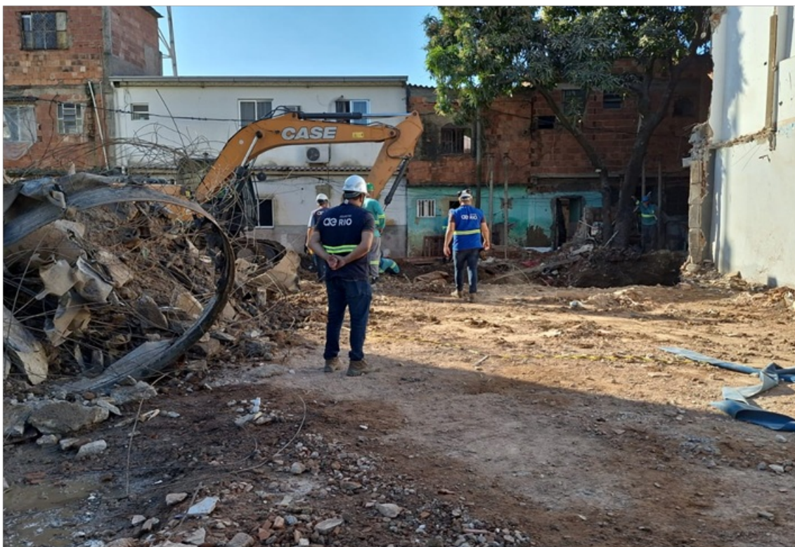
Foto 6 - Finalização dos trabalhos de demolição e limpeza.
