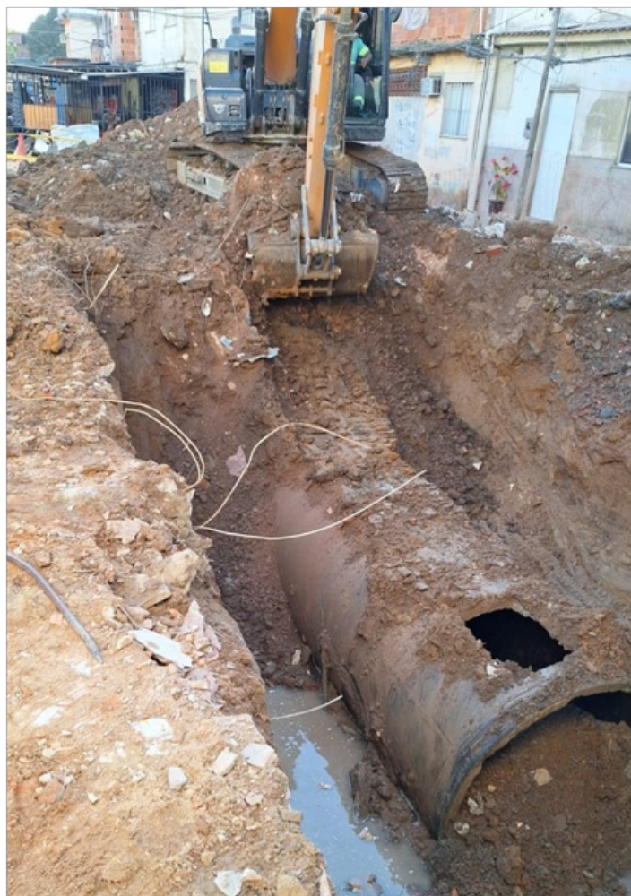
Foto 8 - Início dos trabalhos de escavação para troca da tubulação.
