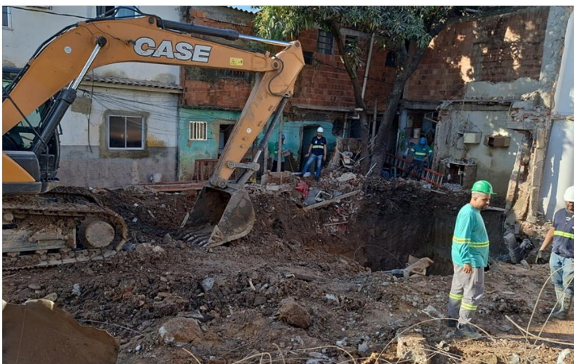
Foto 7 - Finalização dos trabalhos de demolição e limpeza do local.
