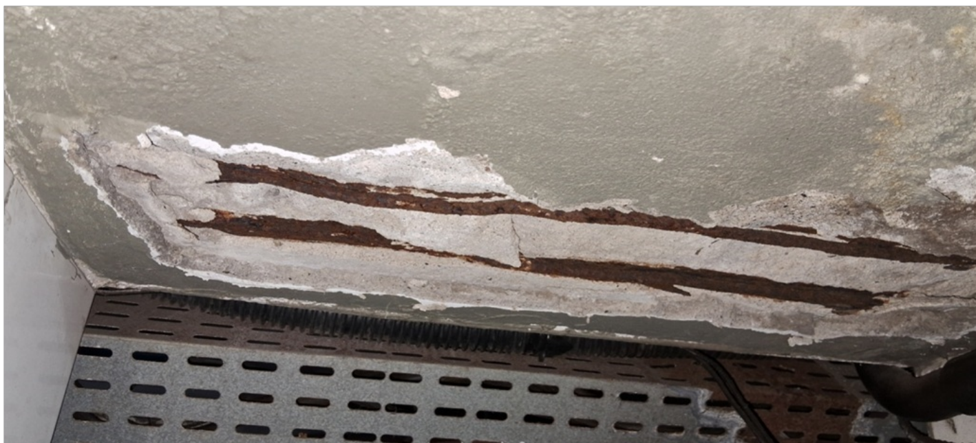
Foto 12 – Armadura exposta.
