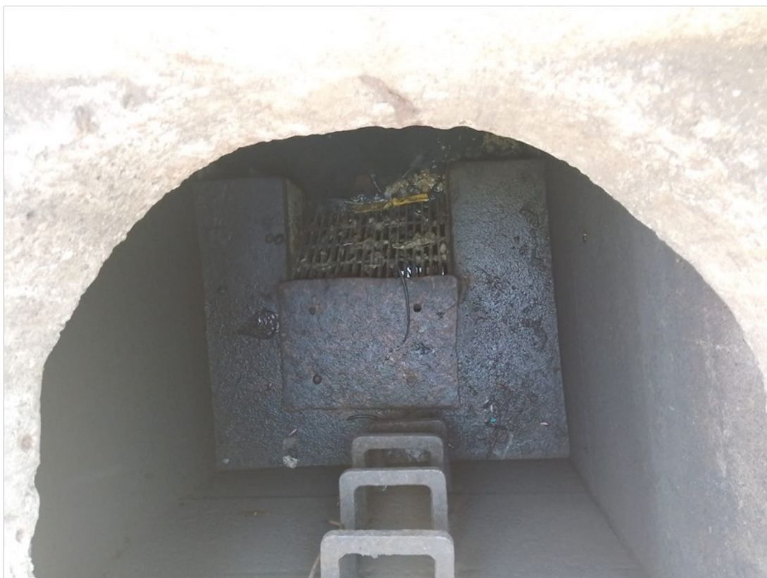
Foto 3 – Interior do poço de gradeamento.
