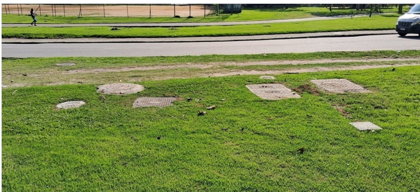
Foto 1 – Vista geral da estação.
