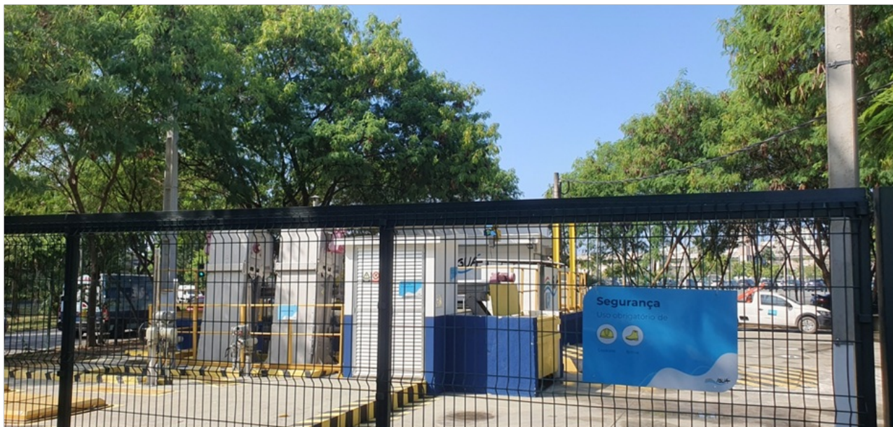
Foto 1 – Vista da entrada da estação
