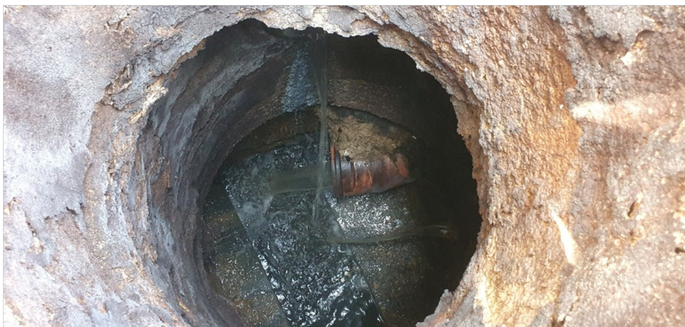
Foto 7 – Vista do interior de um dos poços de visita da rede coletora vistoriados.
