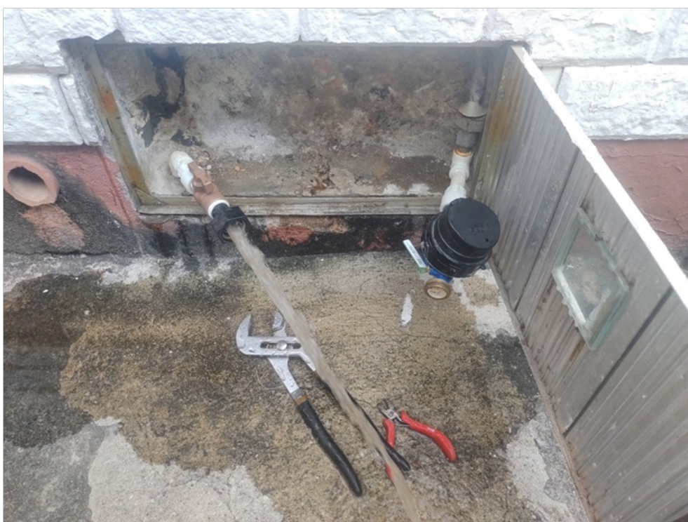
Foto 6 – Tubo de entrada Casa 11 Rua Pereira Soares
