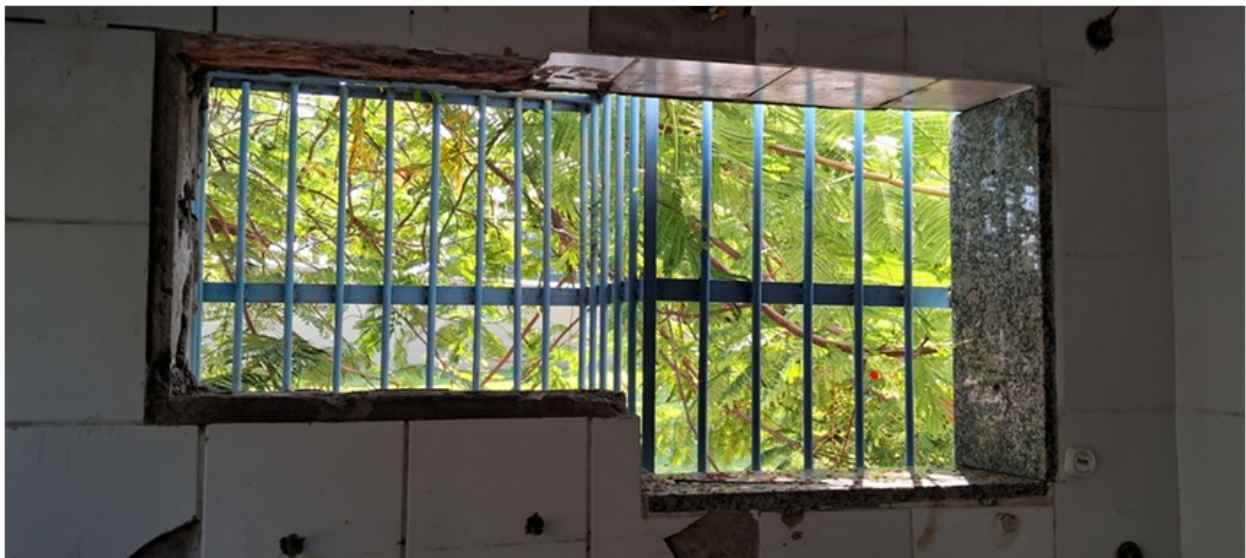
Foto 7 – Janela da sala dos painéis elétricos
