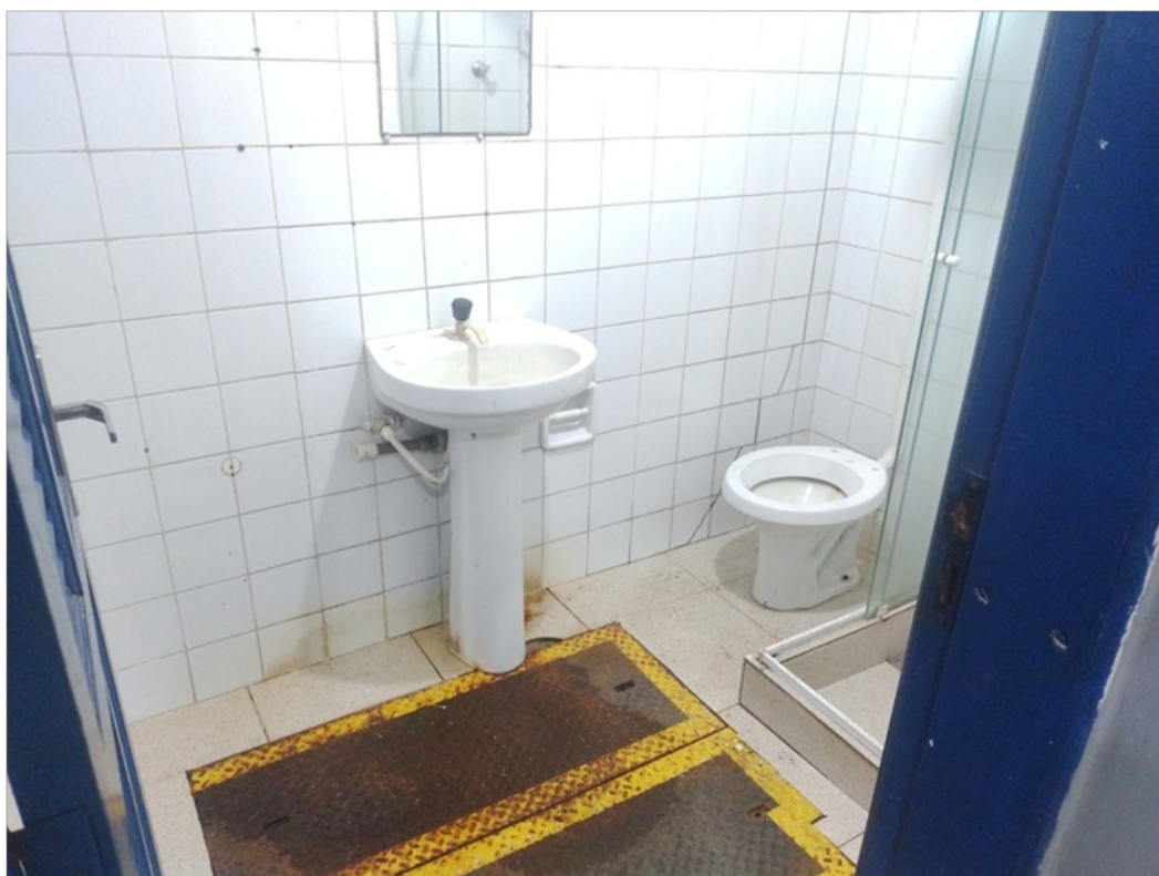
Foto 10 – Banheiro localizado no abrigo
