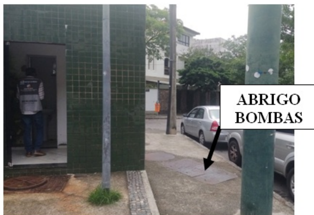
Foto 3 – Abrigo das bombas
