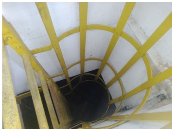
Foto 4 – Escada de acesso ao abrigo das bombas
