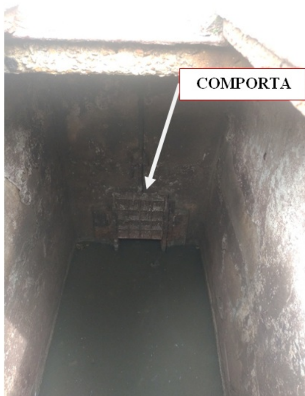
Foto 9 – Poço de visita (Comporta)
