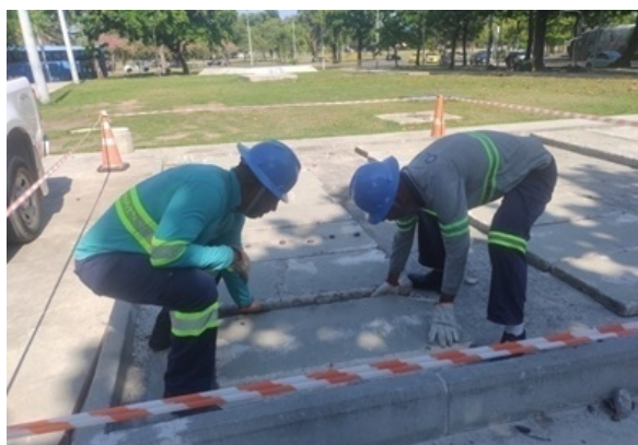
Foto 2 - Remoção tampo poço de visita
