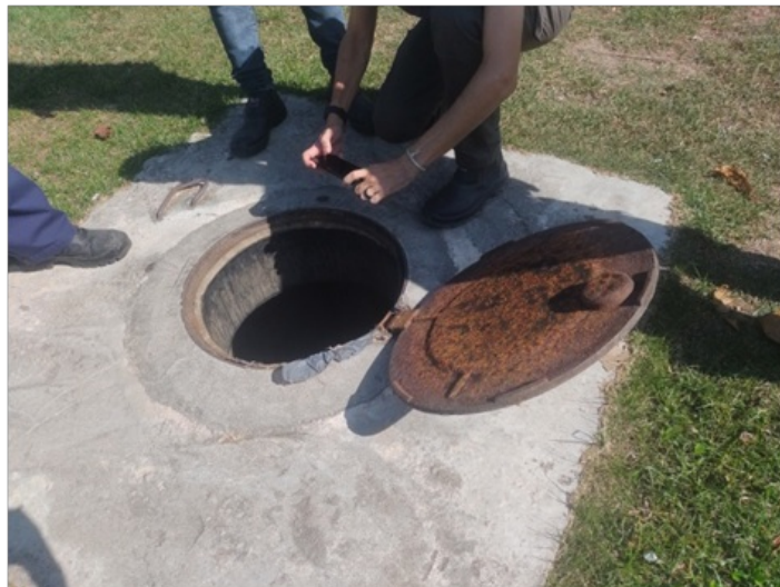
Foto 6 - Poço de visita extravasor
