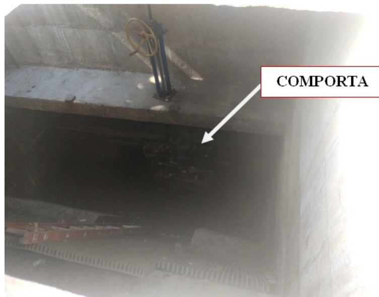
Foto 5 – Poço de visita (Comporta)
