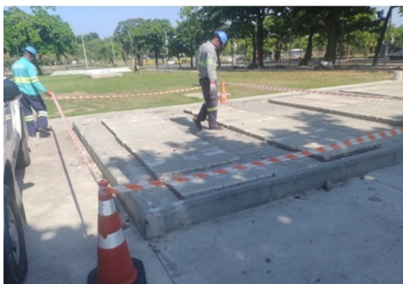
Foto 1 - Isolando área abrigos
