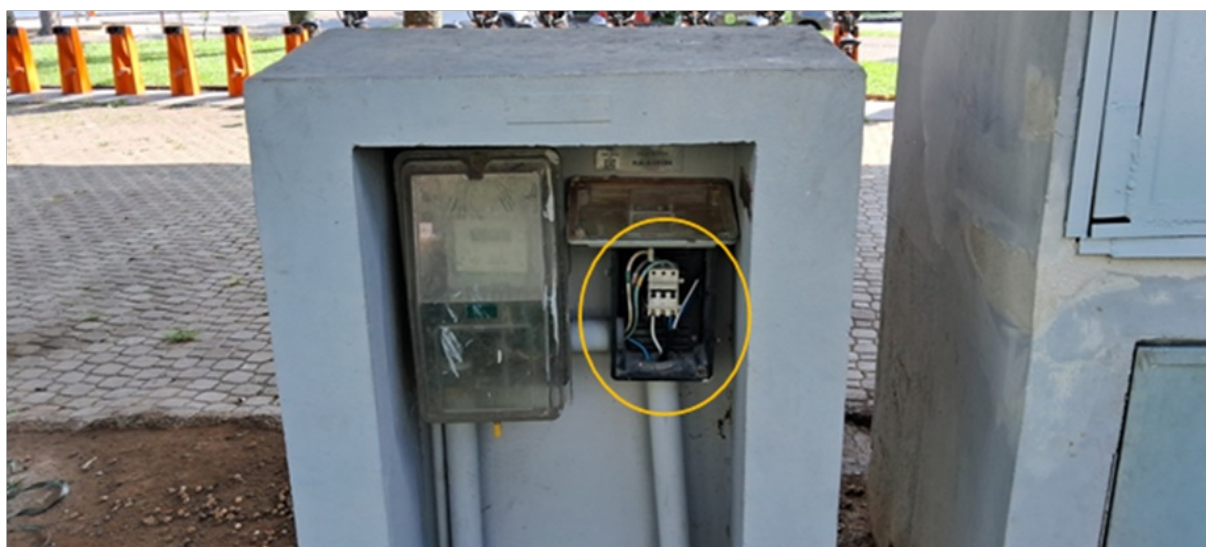
Foto 11 – Abrigos do medidor de energia, dos quadros elétricos e dispositivos de monitoramento
