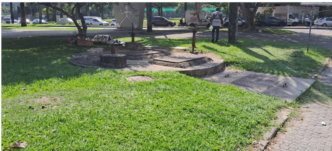
Foto 2 – Vista geral da estação com destaque para o poço de vista
