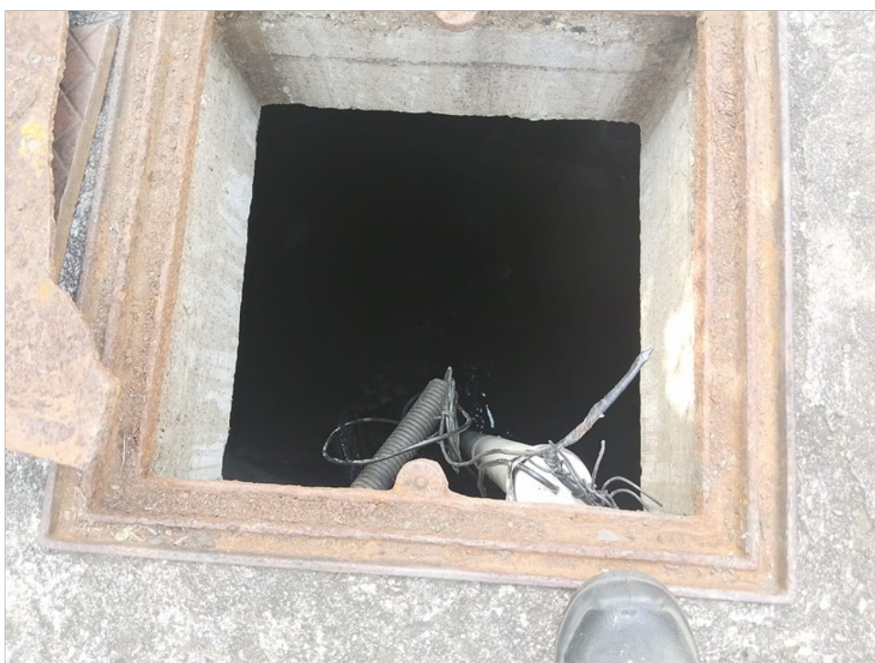
Foto 9 – Vista do poço de visita próximo as comportas
