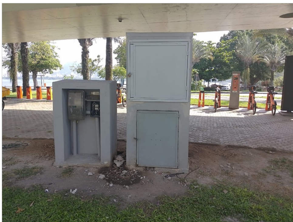
Foto 11 – Abrigos do medidor de energia, dos quadros elétricos e dispositivos de monitoramento
