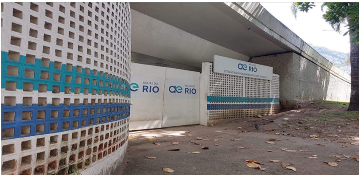
Foto 1 - Vista da fachada da estação elevatória de esgoto.
