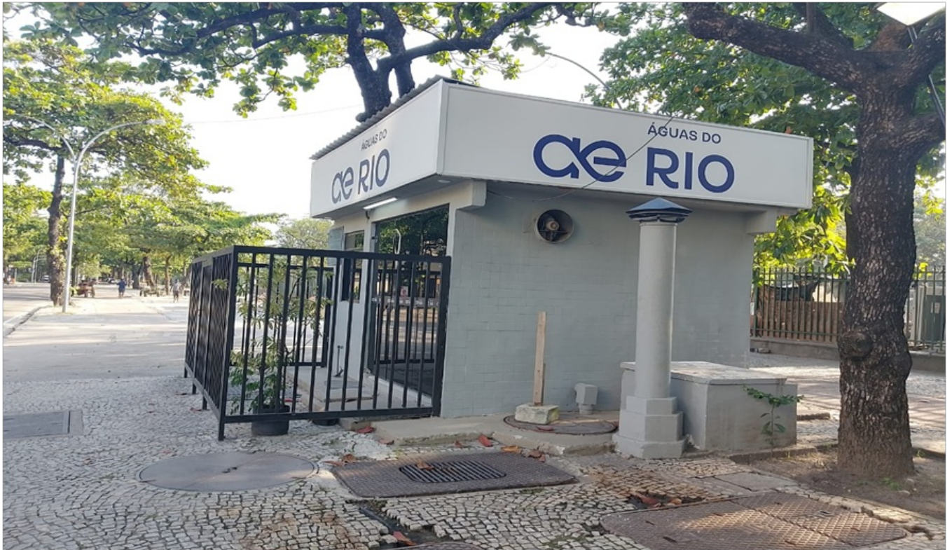
Foto 1- Vista da fachada da Estação Elevatória de Esgoto.
