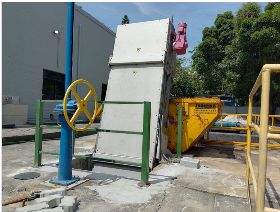
Figura 5 – Gradeamento 2, que estava passando por manutenção no guarda-corpo
