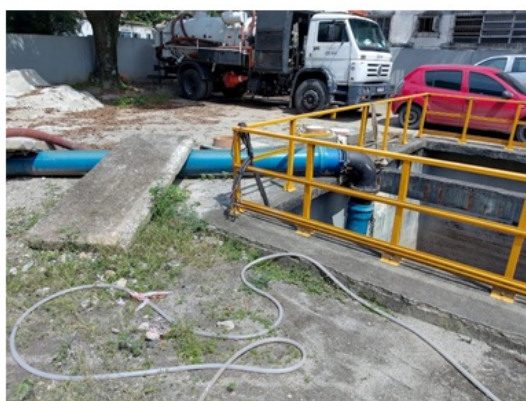
Figura 24 – Placa de concreto apoiada em trecho da linha de recalque.
