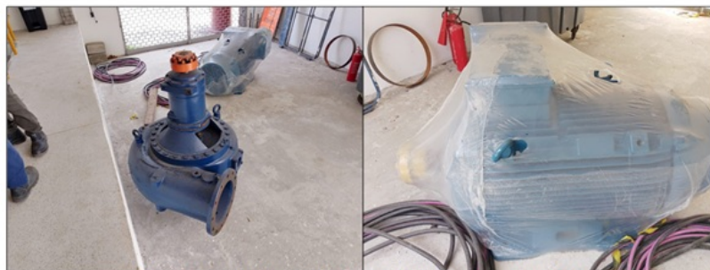
Figura 22 – Bomba d'água e motor novos que estão em processo de instalação.
