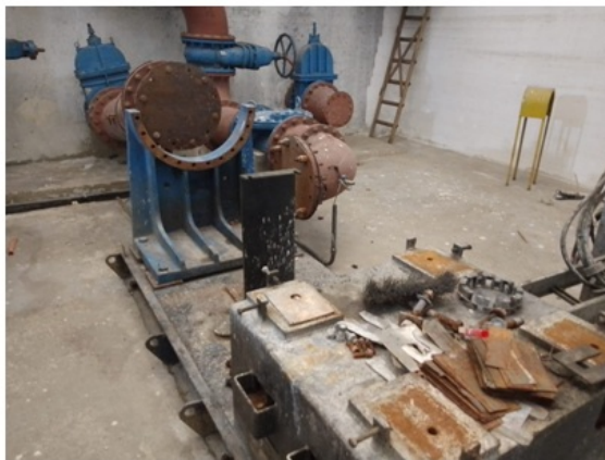
Figura 17 – Area da bomba 1 que está em processo de substituição.
