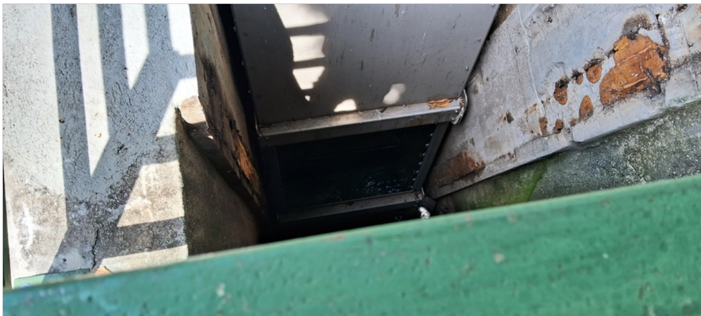
Figura 7 – Vista do fundo do canal do gradeamento 1
