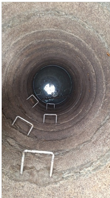
Figura 7 – Poço do gradeamento
