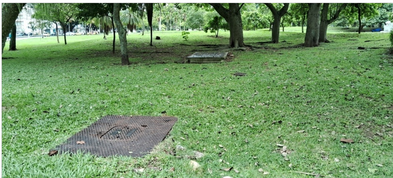
Figura 9 – Tampa metálica do PV onde ocorre a descarga do efluente recalcado
