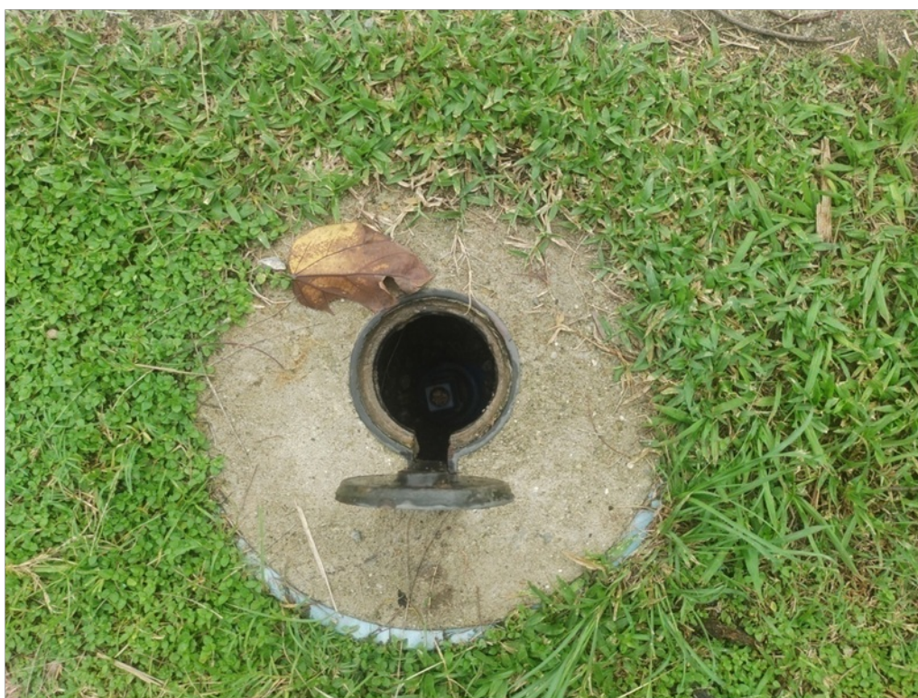
Figura 6 – Detalhe de um dos registros da tubulação de recalque
