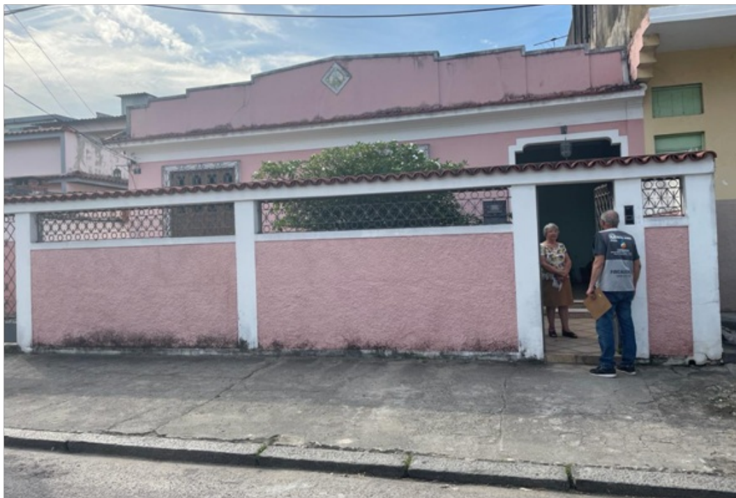
Foto 1 - Vistoria no imóvel nº 21 da rua Quiroa, no bairro de Osvaldo Cruz.
