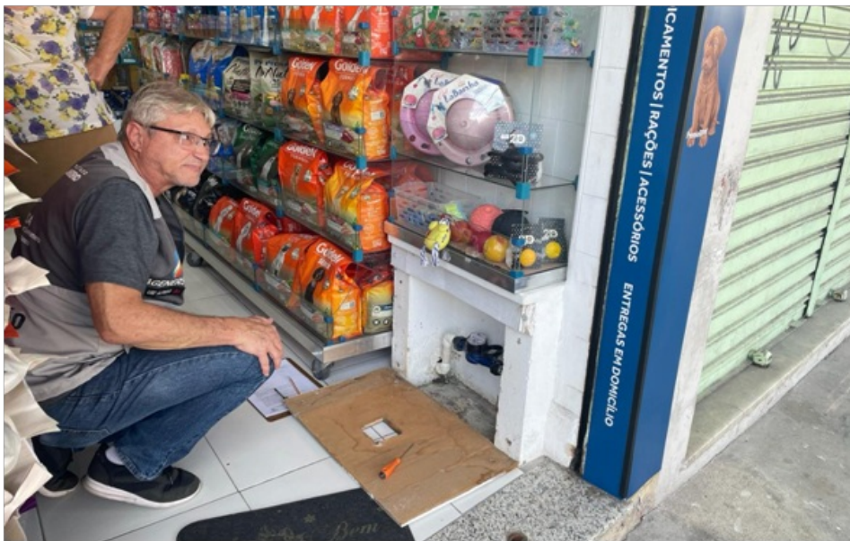
Foto 3 - Remoção da tampa de madeira, pela equipe da AGENERSA/CASAN, para verificação das condições do hidrômetro.
