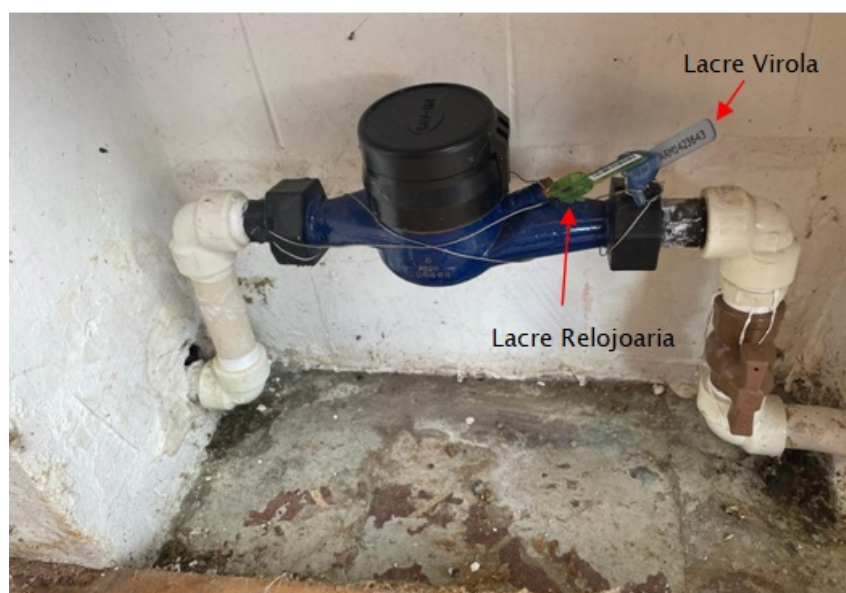
Foto 5 - Hidrômetro com visor fechado e identificação dos lacres.
