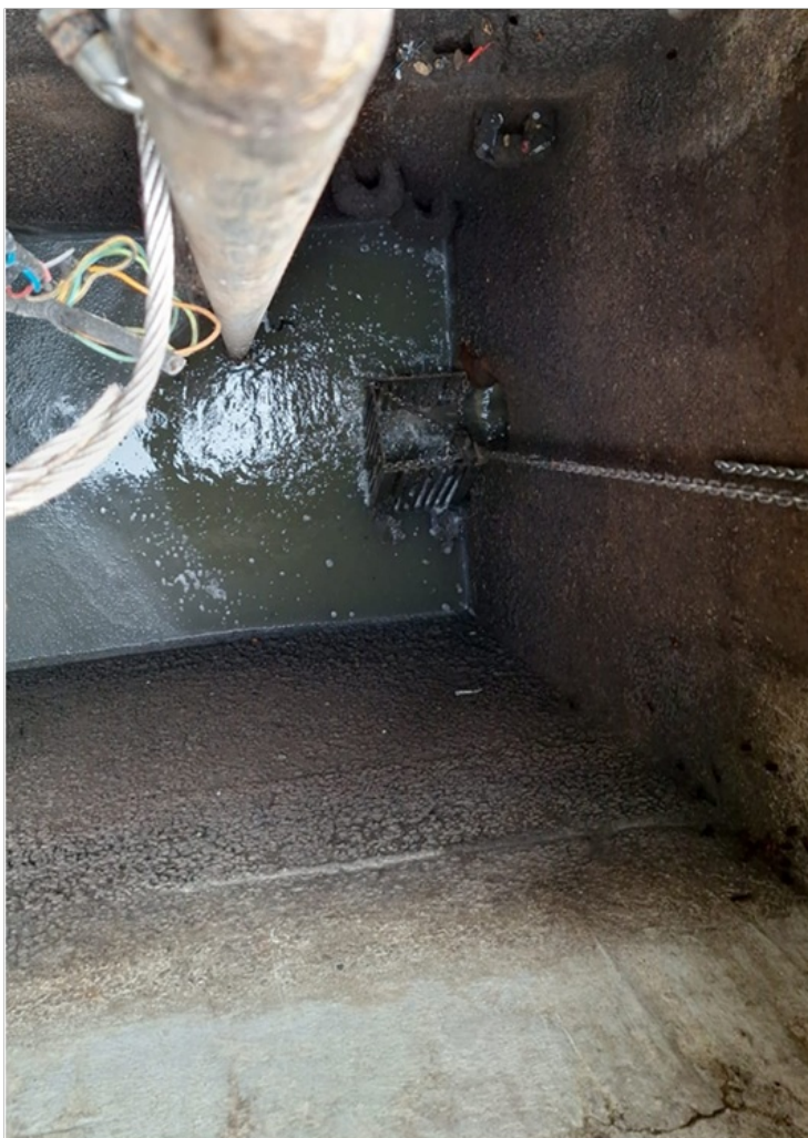
Figura 6 – Gradeamento executado com cesto metálico
