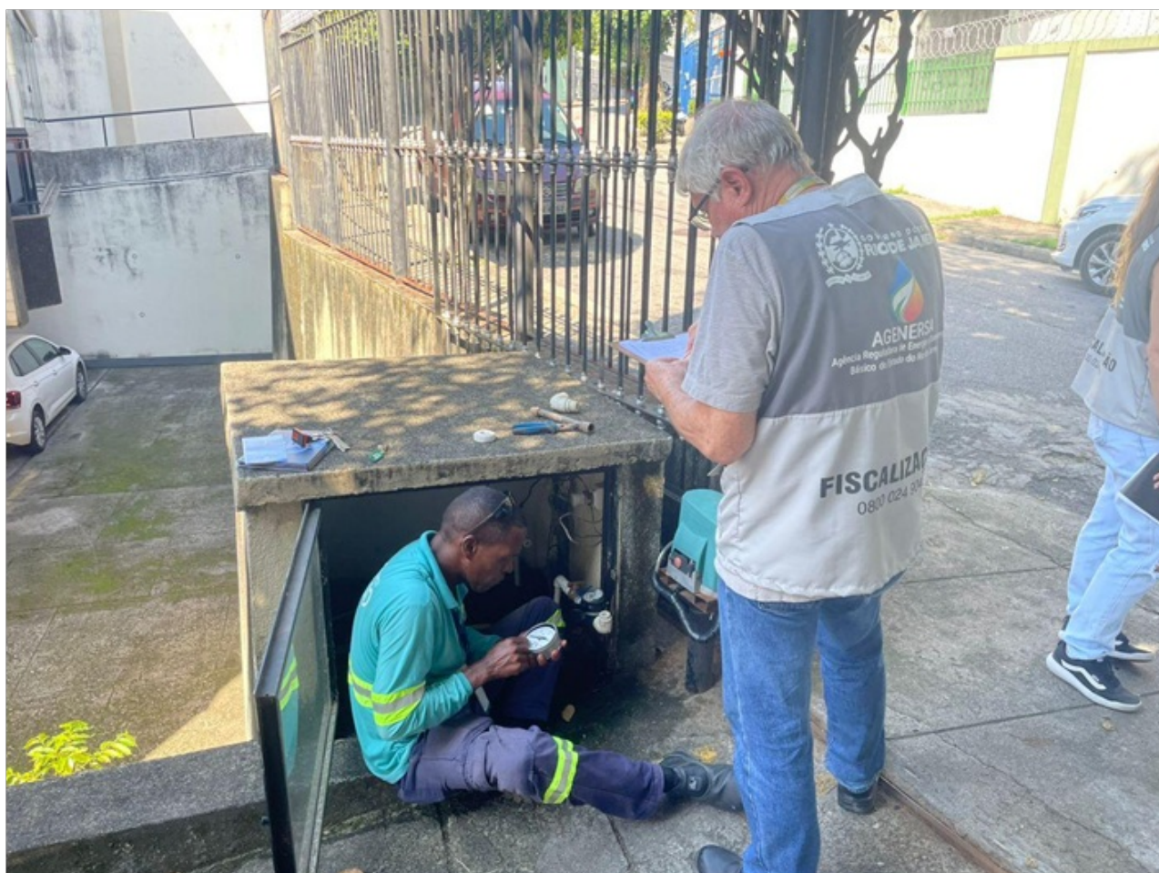
Foto 4 – Medição de pressão manométrica na entrada de água do imóvel nº 396 da rua Formosa.
