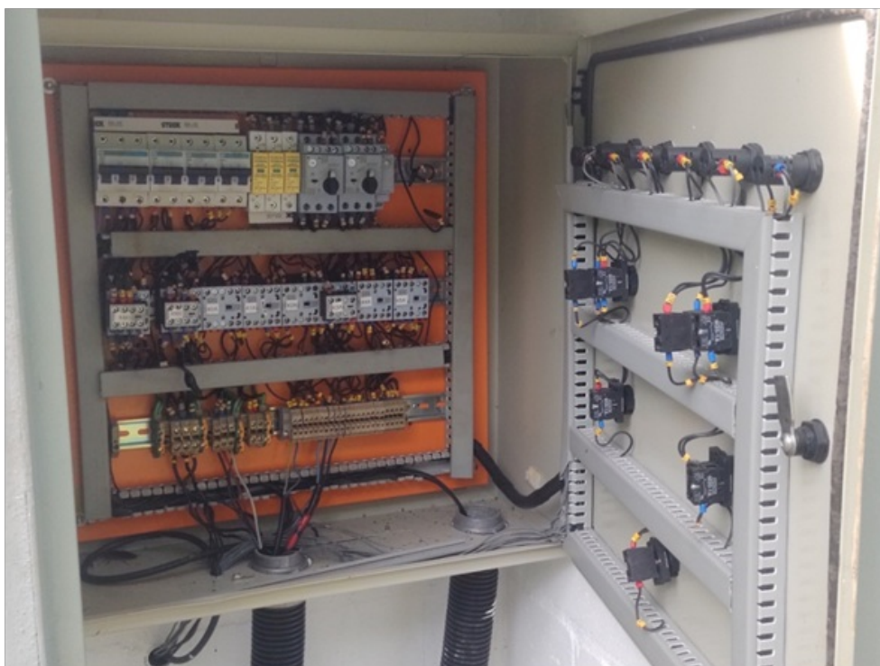
Foto 6 - Painel de comando elétrico.
