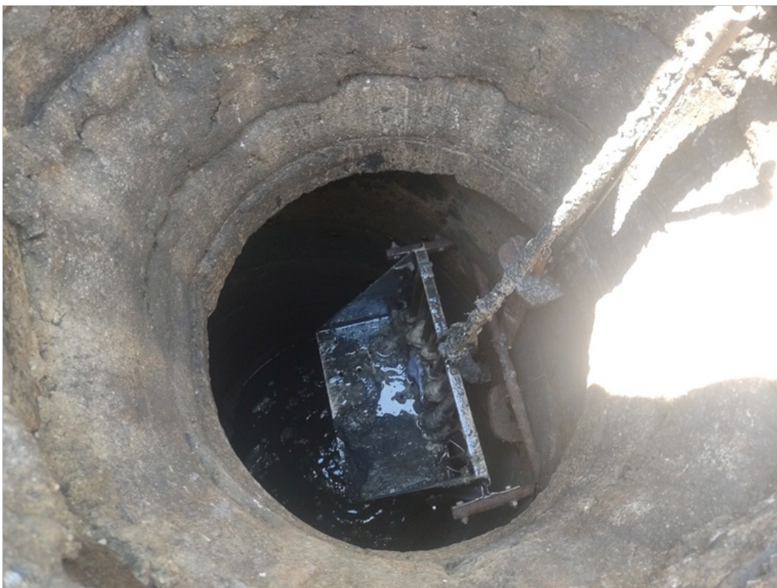
Figura 3 – Içamento do gradeamento para retirada de resíduos.
