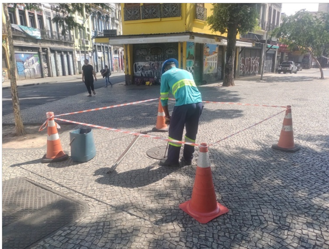
Figura 2 – Operador abrindo o acesso ao poço de gradeamento.
