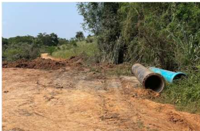
Foto 4 - Local dos trabalhos do vazamento.
