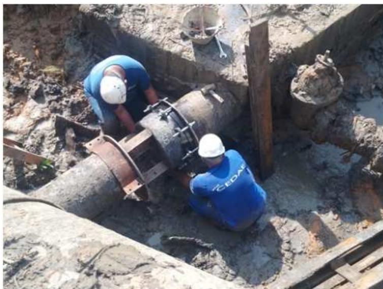
Foto 12 - Finalização do trabalho de capeamento da tubulação DN 400
