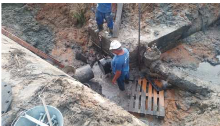
Foto 11 - Trabalho de capeamento sendo executado na tubulação DN 400.
