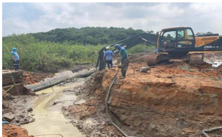
Foto 8 - Trabalhos de escavação em andamento.
