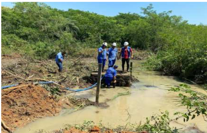
Foto 3 – Equipe de colaboradores trabalhando no bombeamento da água acumulada do vazamento para posterior localização do mesmo.
