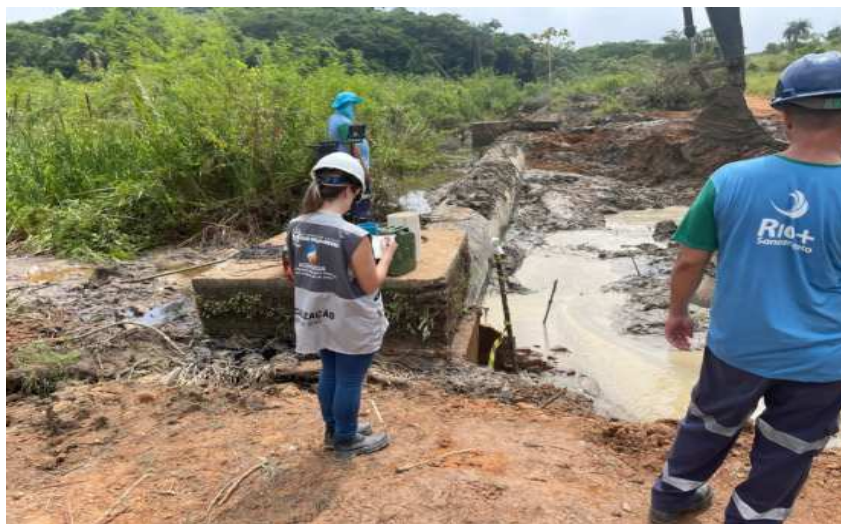
Foto 9 - Equipe de fiscalização CASAN atuando no acompanhamento dos trabalhos.
