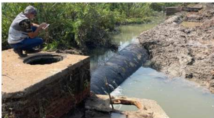
Foto 5 – Localização da adutora de 1750 mm.
