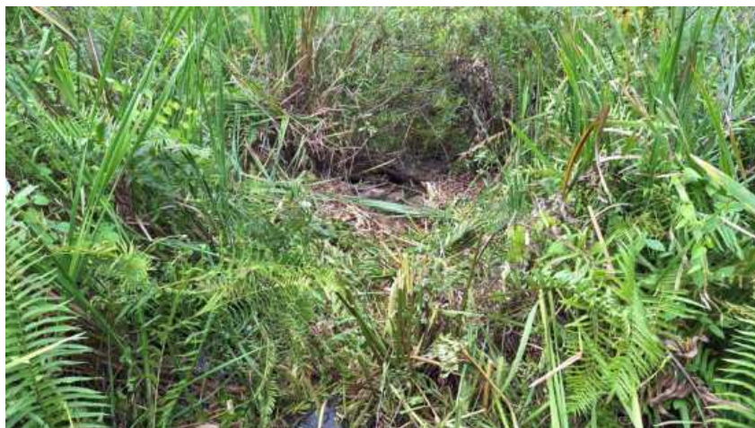
Foto 7 - Localização do ponto de vazamento na tubulação DN 400.
