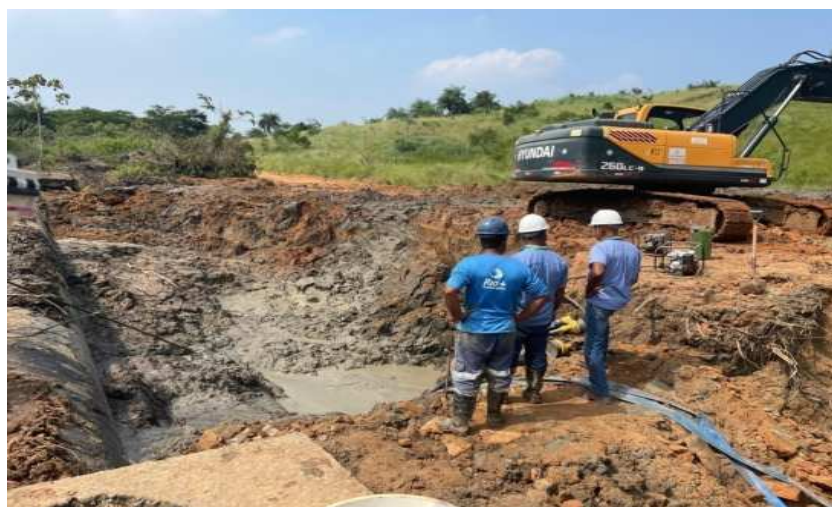
Foto 10 - Trabalhos de escavação em andamento.
