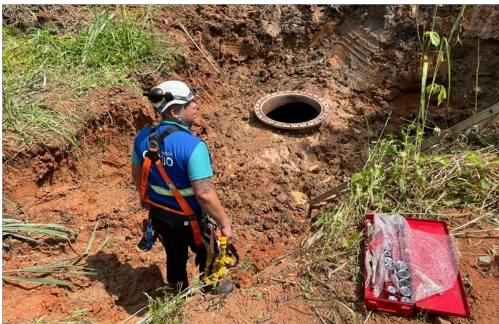
Foto 3 – Trabalho de escavação do solo já realizado e janela de acesso à adutora aberta
