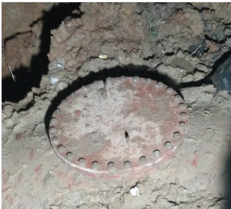
Foto 8 - Finalização dos trabalhos com fechamento da adutora.
