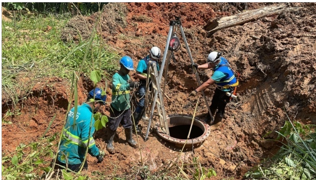
Foto 4 - Colaboradores da concessionária em preparação para adentrar no interior da tubulação
