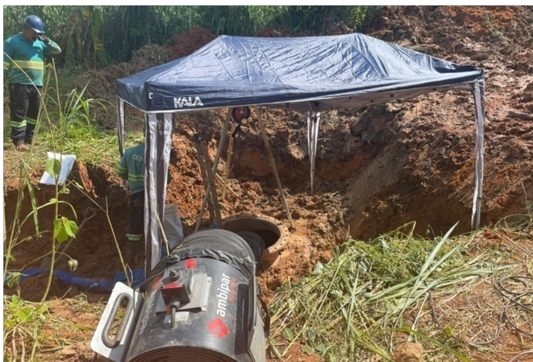
Foto 5 - Trabalho de identificação do diagnóstico do vazamento em andamento no interior da tubulação
