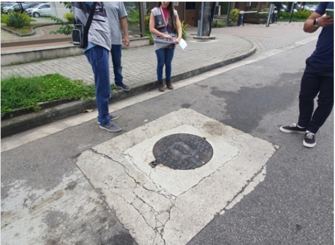
Foto 4 - Primeiro PV vistoriado, localizado na entrada do condomínio
