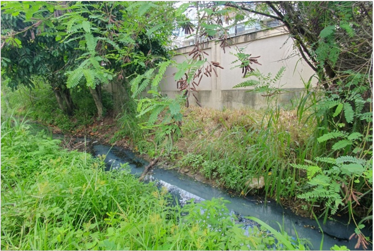
Foto 14 – Continuação da vala com indícios de esgoto a céu aberto, encontrada na rua atrás do condomínio.
