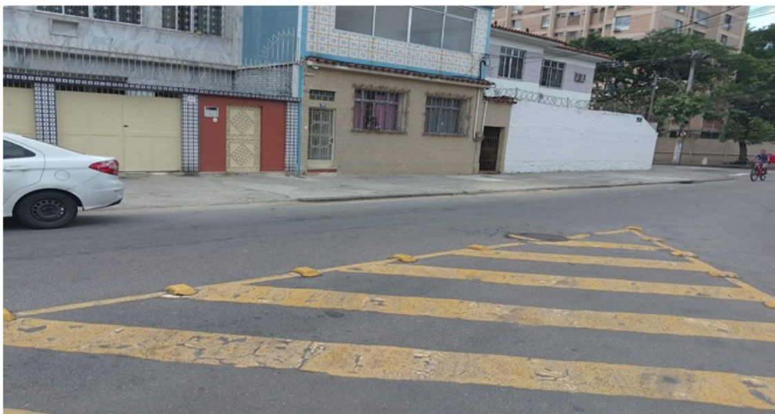
Foto 3 – Rua Nossa Senhora de Lourdes próximo ao nº 65, bairro Grajaú.
