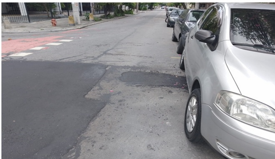
Foto 2 – Marcas de obras Rua Nossa Senhora de Lourdes, bairro Grajaú.
