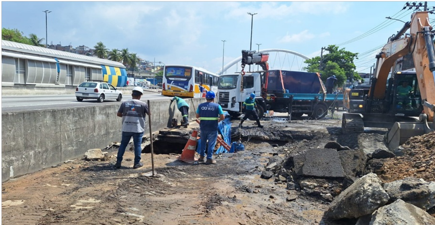
Foto 2 - Mobilização com Munck, Gerador, Bombas sapo, Escavadeira hidráulica, Policorte, Equipe de manutenção.
