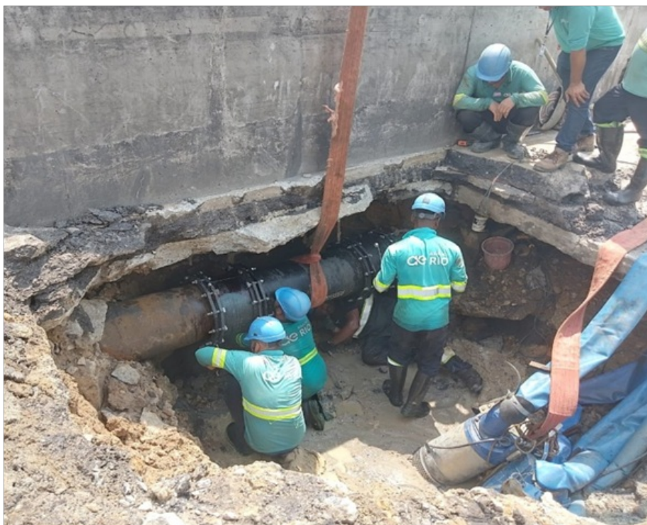
Foto 6- Recolocação de nova tubulação com 2 juntas mecânicas DN 400 mm.
