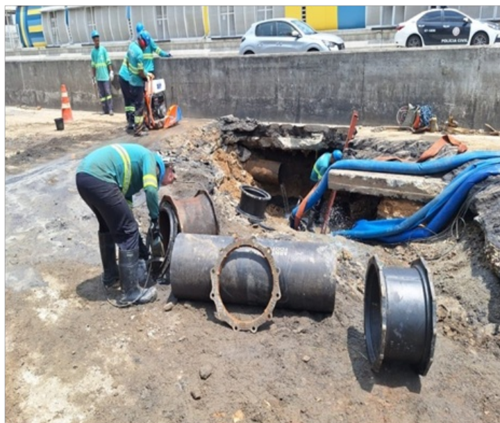
Foto 4 - Juntas mecânicas DN 400 mm.
