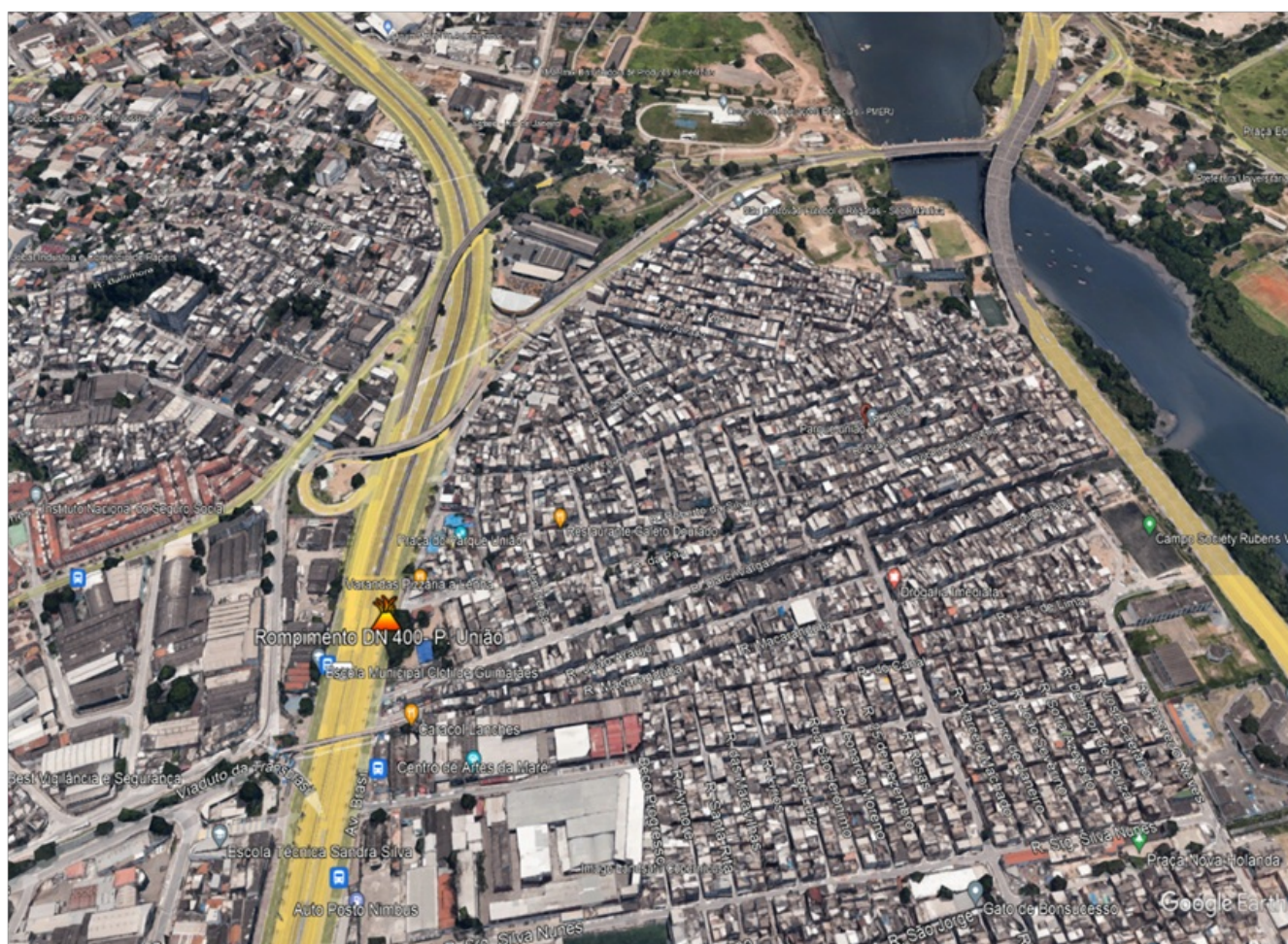
Foto 1 – Vista do local do vazamento na Av. Brasil em frente ao Parque União, próximo a entrada da Ilha do Fundão.
