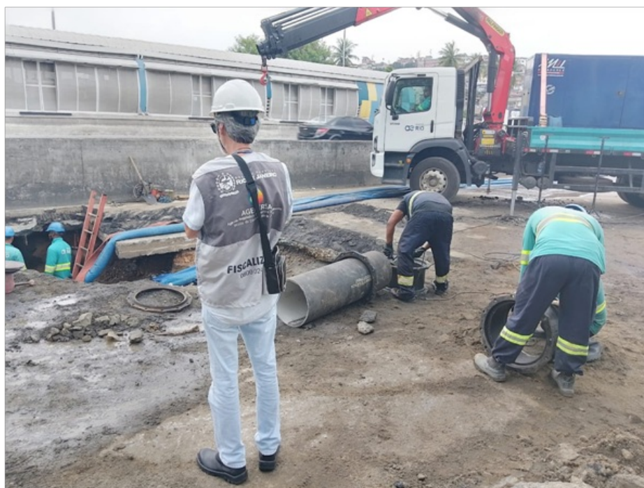
Foto 5 – Ajustes das juntas mecânicas DN 400 mm.
