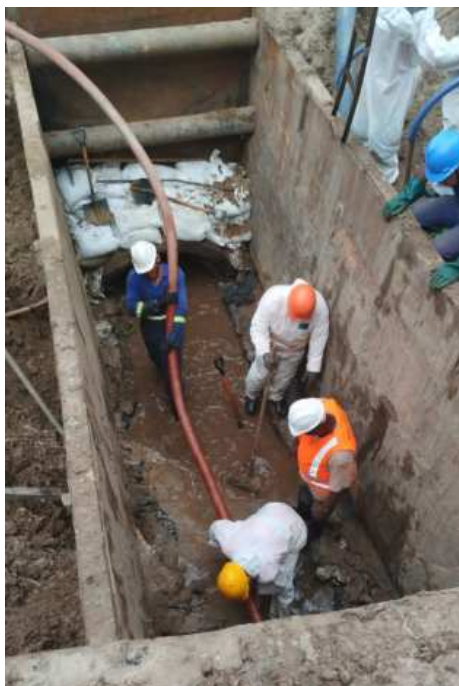
Figura 15 – Escoramento e esgotamento da vala com rebaixamento de lençol freático (1/1/24)
