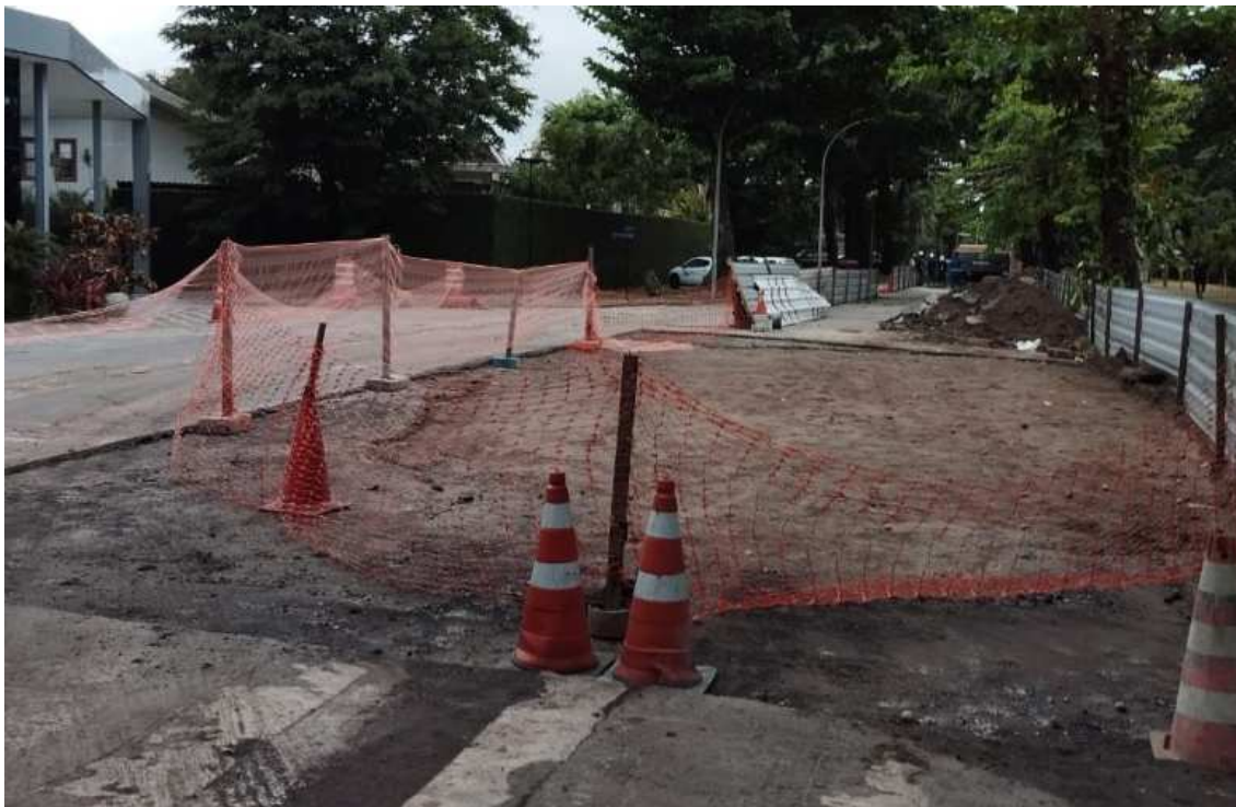
Figura 17 – Finalização do reparo do 1º colapso (2/1/24)
