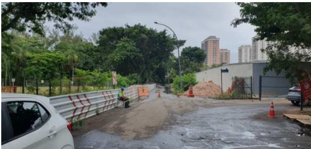
Figura 4 – Obras ao longo da Av. Pref. Dulcídio Cardoso (30/12/23)
