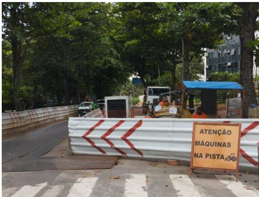
Figura 10 – Canteiro de obras do poço de cravação do MND Shield (30/1/23)
