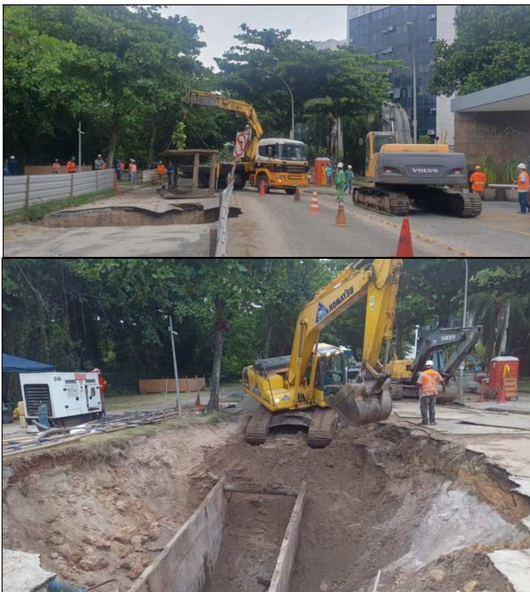
Figura 14 – Preparação da vala com escavação e escoramento para troca de tubo colapsado (1º)
