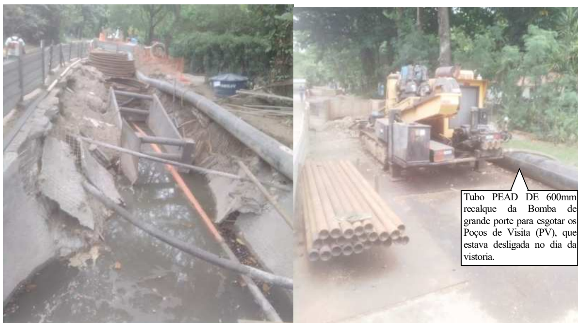
Figura 9 – Execução de HDD com PEAD DE 1000mm dentro do tubo existente DN1200mm, colapsado (2/1/24)
