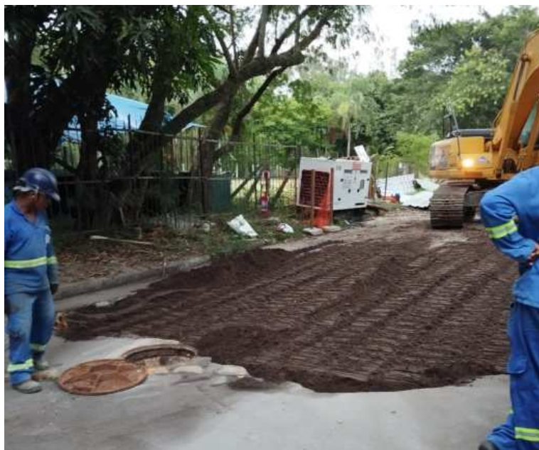
Figura 19 – Finalização do reparo do 2º colapso do Coletor Tronco Novo Leblon (2/1/24)
