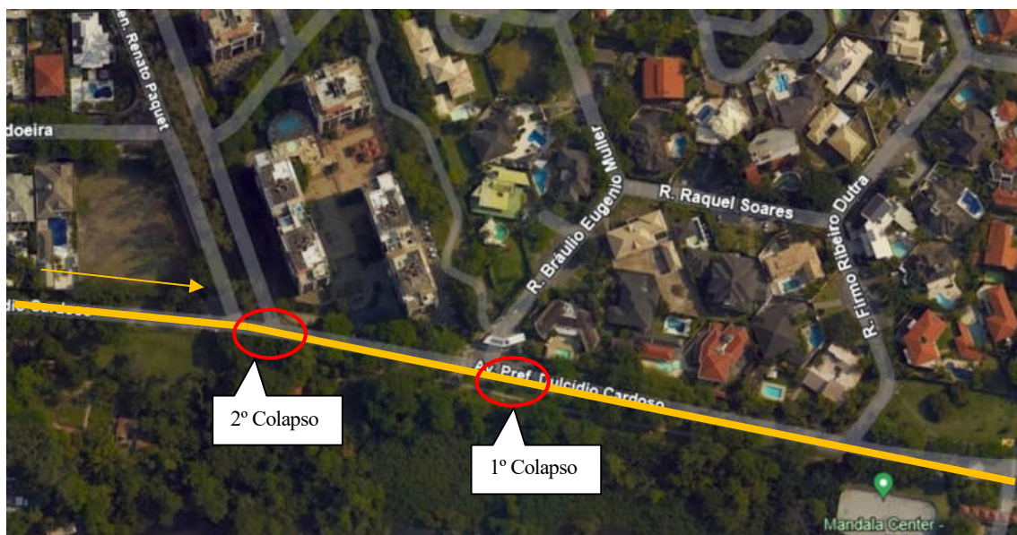
Figura 1 – Localização dos colapsos vistoriados
