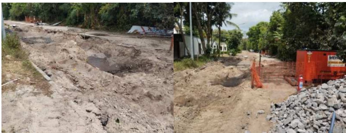
Figura 8 – Trecho inicial do coletor tronco que foi recuperado em VCA (2/1/24)
