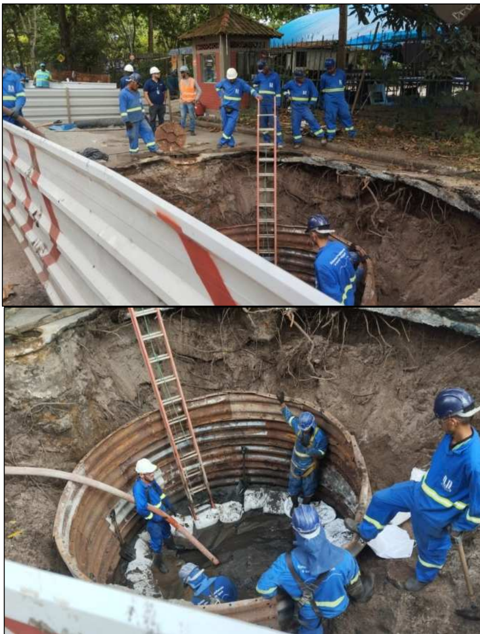
Figura 18 – Reparo do 2º colapso no Coletor tronco Novo Leblon (2/1/24)
