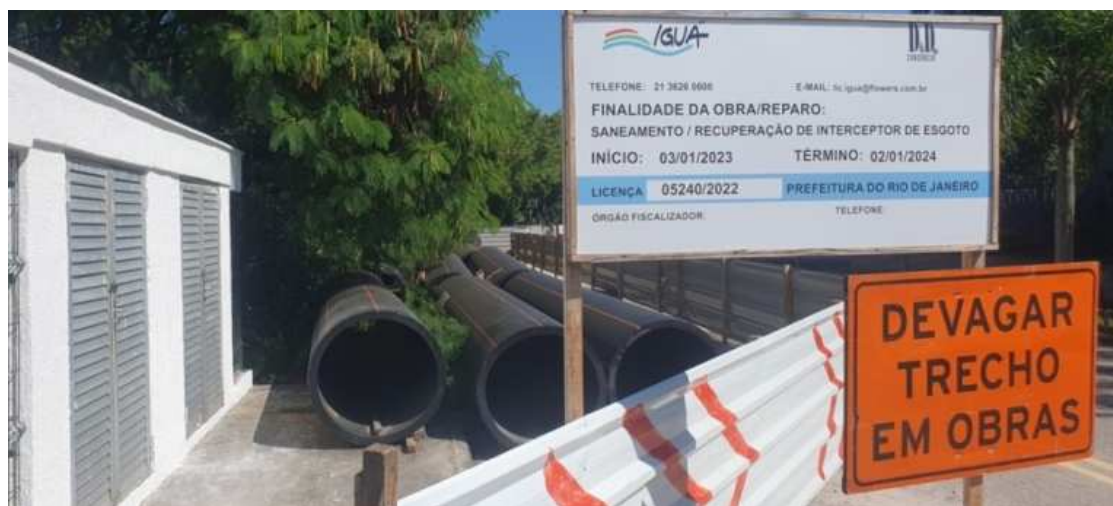
Figura 3 – Canteiro de Obras e Placa de Obra na Av. Pref. Dulcídio Cardoso, em frente a elevatória Marapendi
