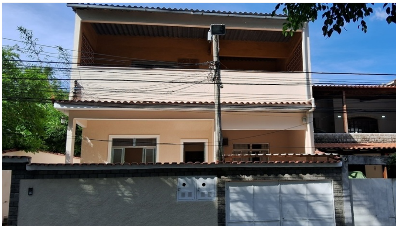
Foto 2 – Imóvel nº 3 da rua Raul Azedo Neto.
