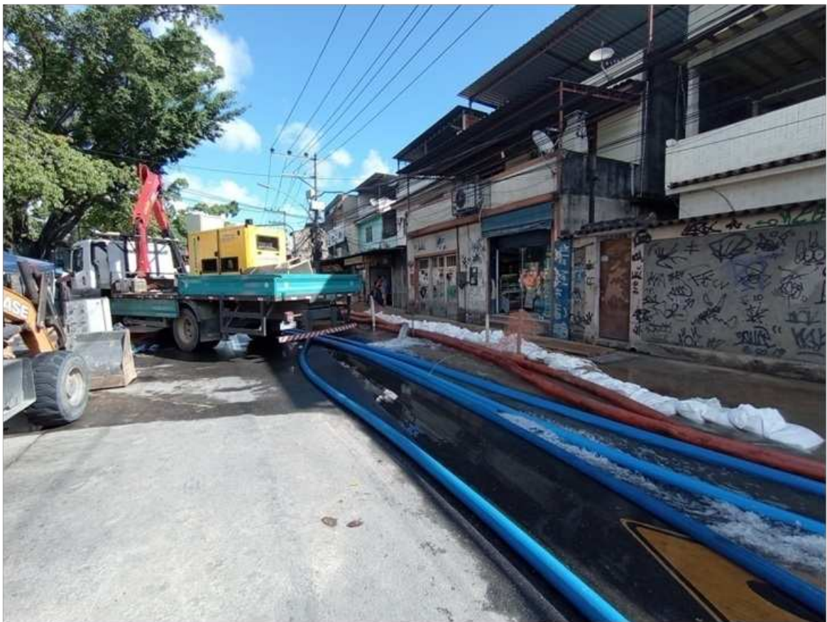
Figura 6 - Equipamentos observados quando da chegada da equipe ao local (caminhão munck, retro escavadeira, gerador, mangotes)
