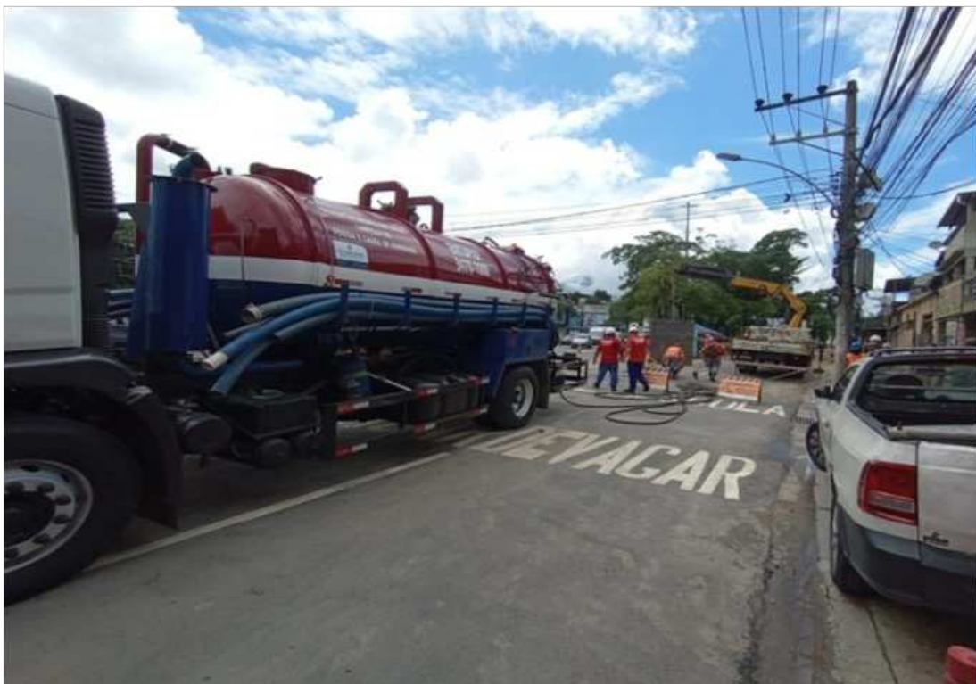
Figura 16 - Caminhão combinado limpa fossa fazendo a limpeza do local
