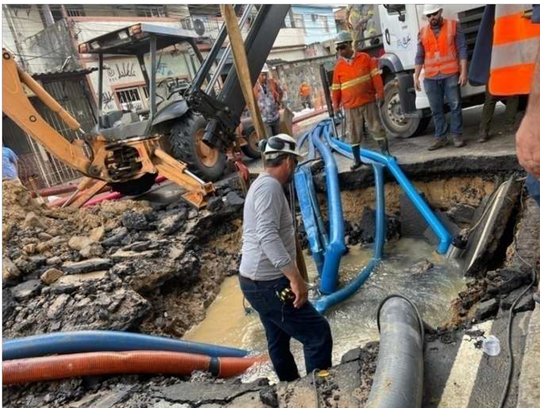
Figura 11 - Após horas sem sucesso, entrou em operação mais uma bomba. A água começou a baixar o nível
