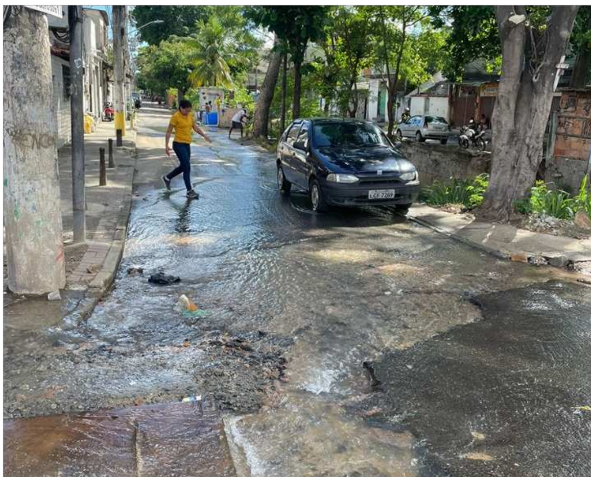
Figura 4- Córrego próximo ao local para onde a água do vazamento estava escoando
