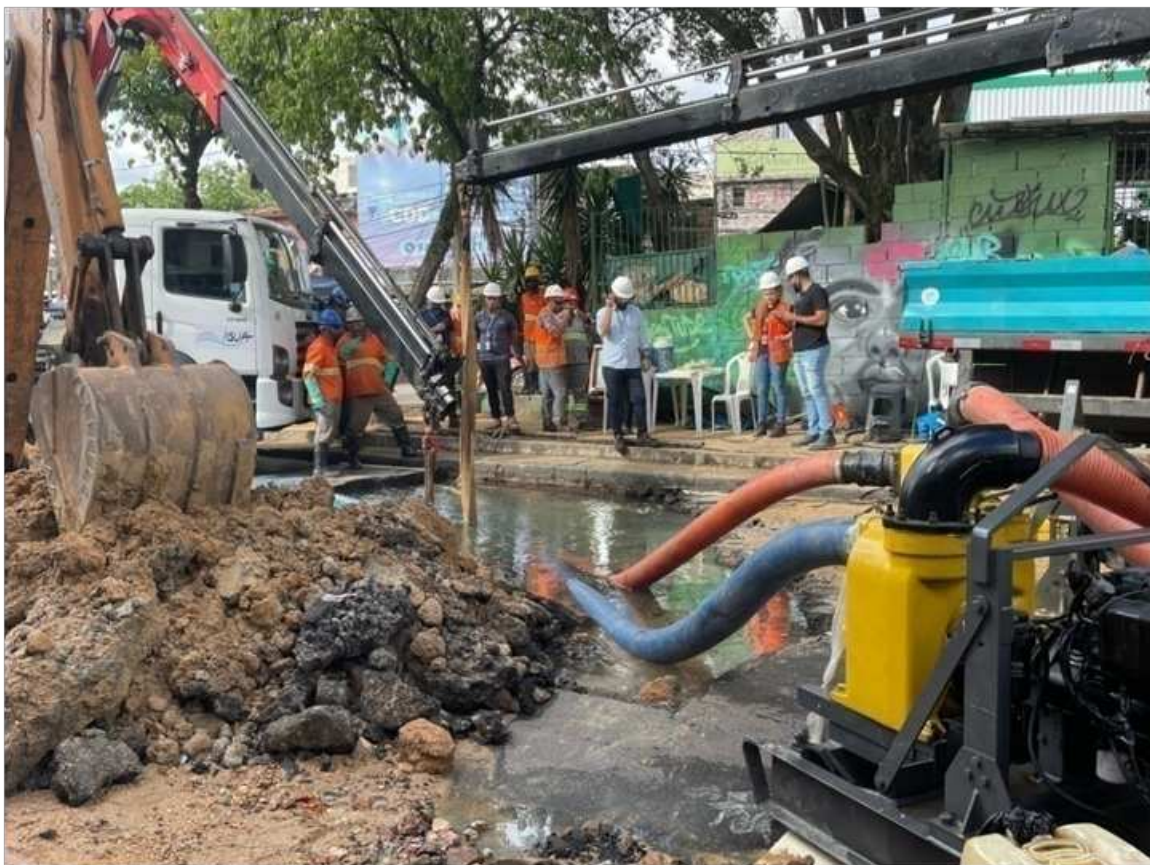
Figura 10 - Bombas esgotando um grande volume de água dentro da vala, para encontrar a tubulação rompida
