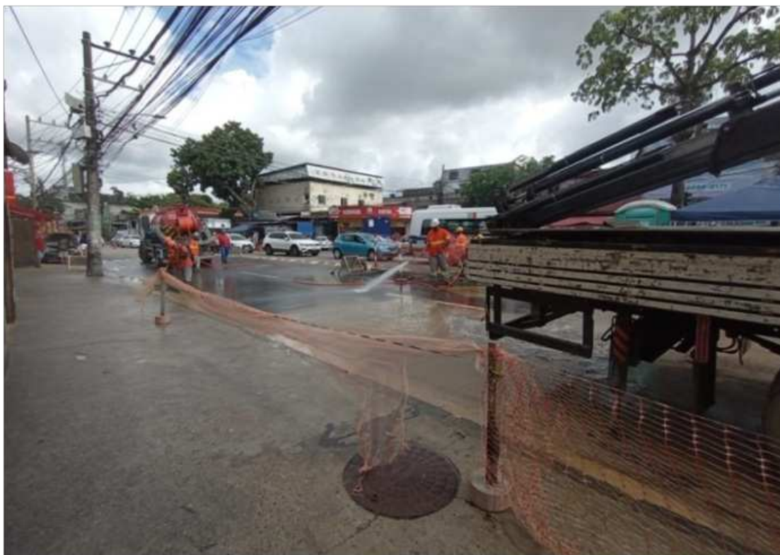
Figura 17 - Colaboradores realizando a limpeza final do asfalto, após a finalização dos reparos
