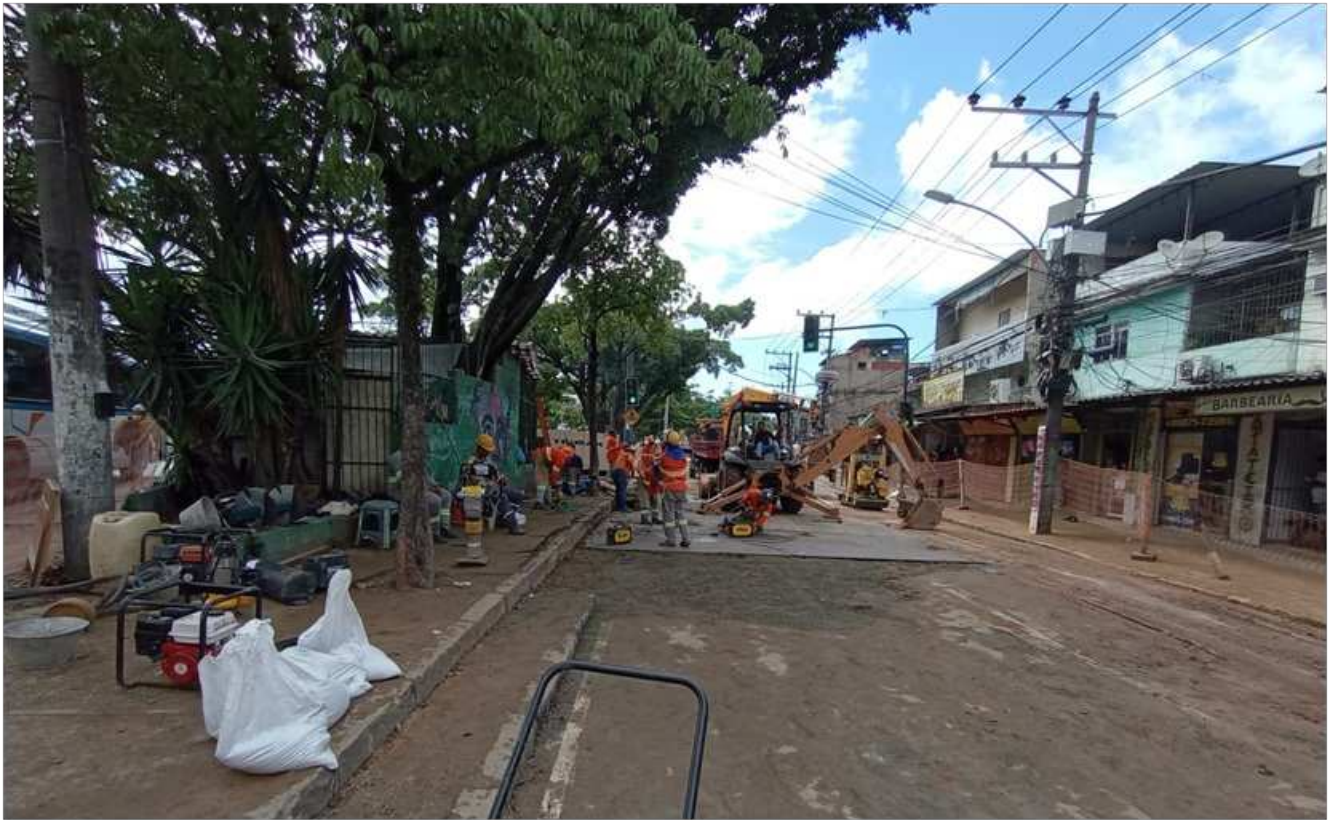
Figura 21 - Equipe de colaboradores trabalhando com o auxílio de maquinário para a colocação de chapas de aço
