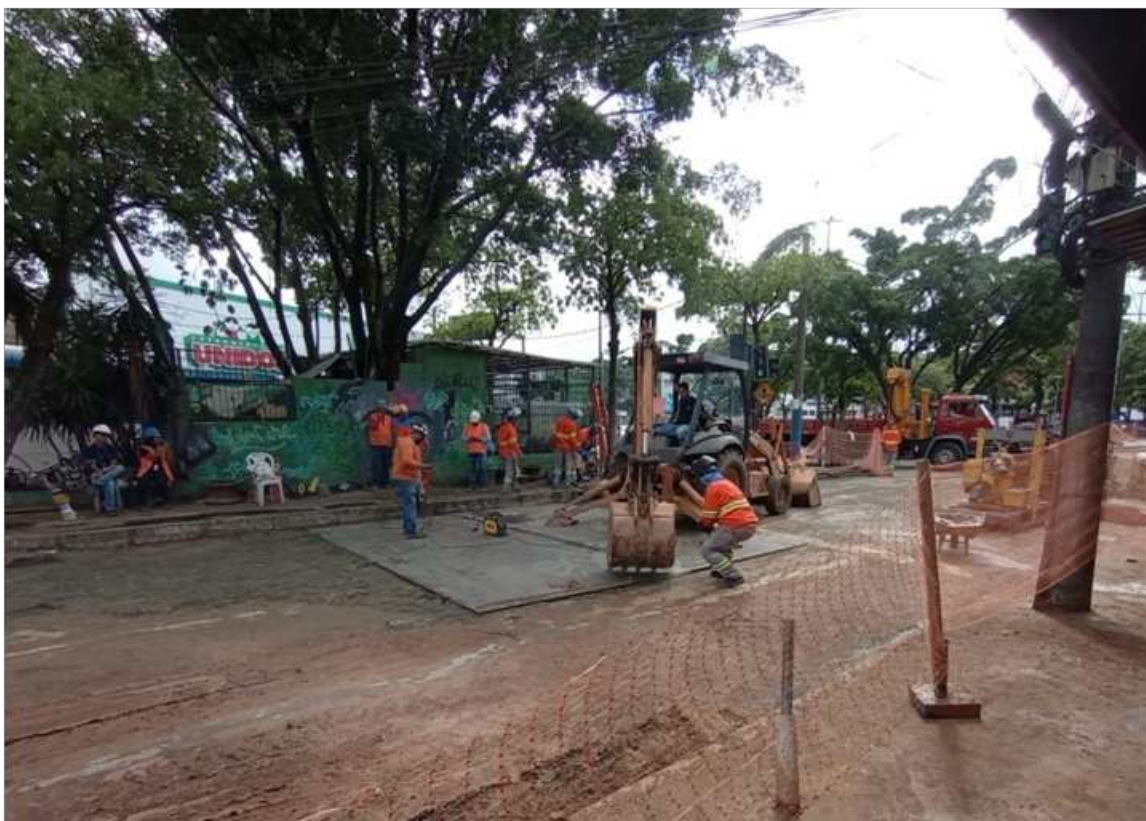
Figura 19 - Equipe de colaboradores trabalhando com o auxílio de maquinário para a colocação de chapas de aço
