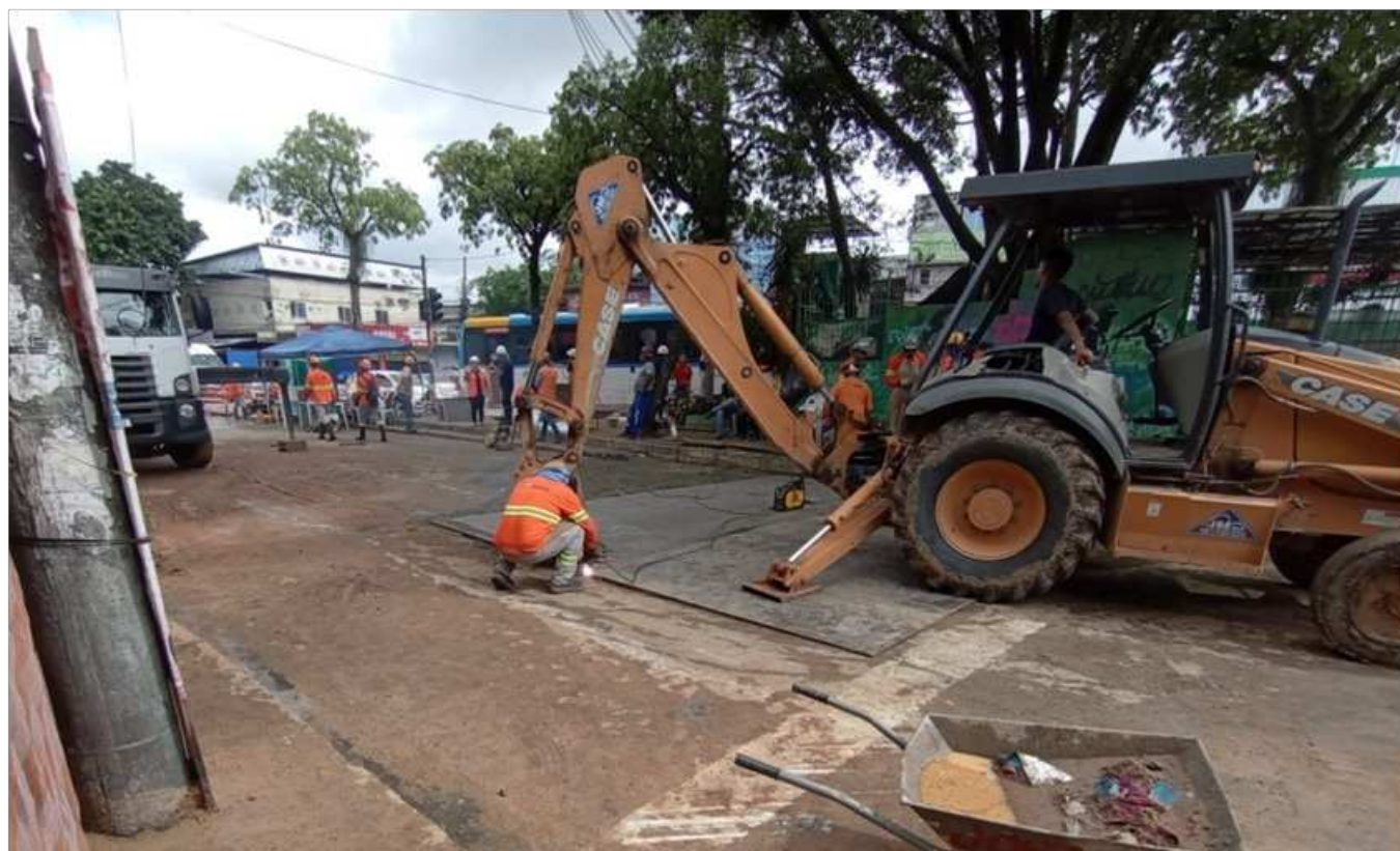
Figura 20 - Equipe de colaboradores efetuando pontos de solda, com o auxílio de maquinário, nas chapas de aço
