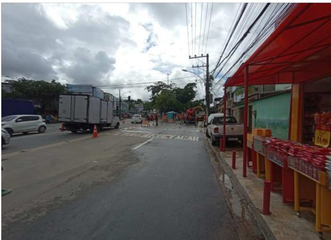
Figura 18 - Colaboradores realizando a limpeza final do asfalto, após a finalização dos reparos
