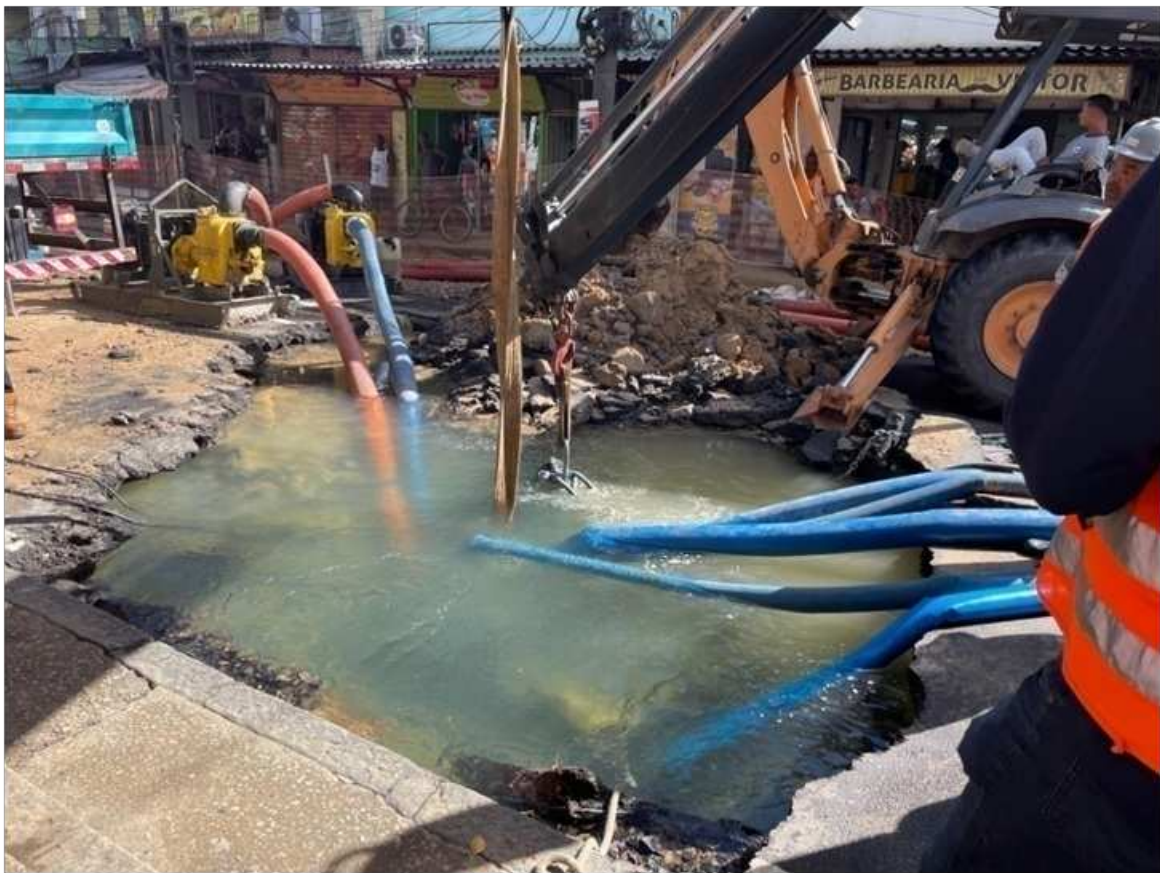
Figura 9 - Bombas esgotando um grande volume de água dentro da vala, para encontrar a tubulação rompida
