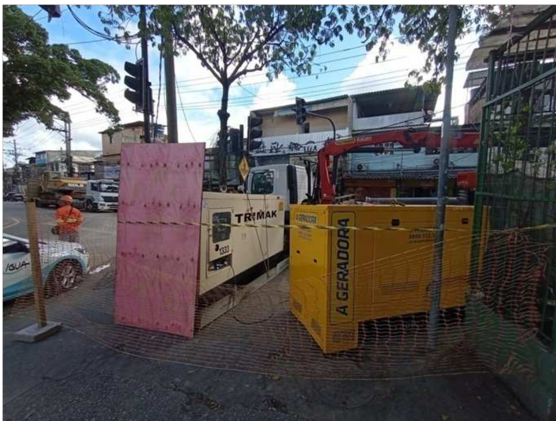
Figura 8 - Equipamentos observados quando da chegada da equipe ao local ( gerador, caminhão munck, escavadeira hidráulica)
