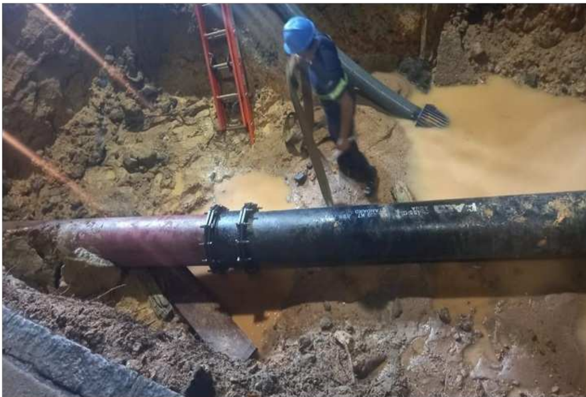
Figura 13 - Finalização do reparo com a troca da tubulação rompida e nova conexão efetuada
