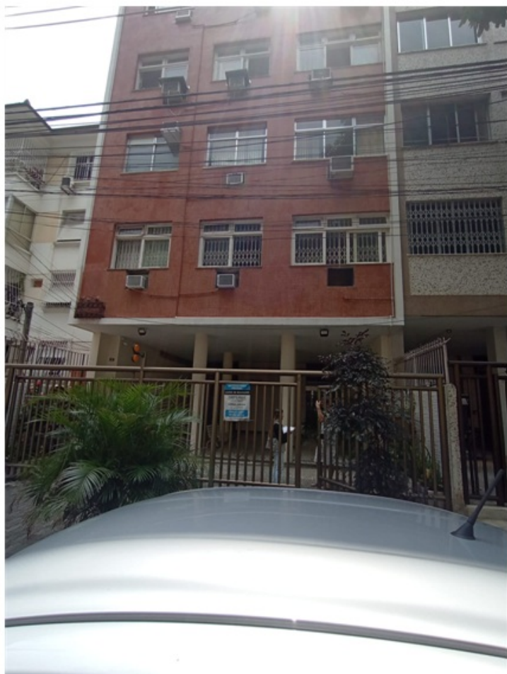
Foto 1 – Fachada frontal do prédio residencial nº 31 da rua Aguiar
