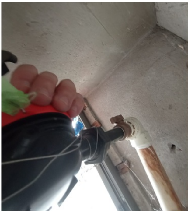
Foto 7 – Arame do selo de virola envolvendo o tubete, a virola e o hidrômetro.
