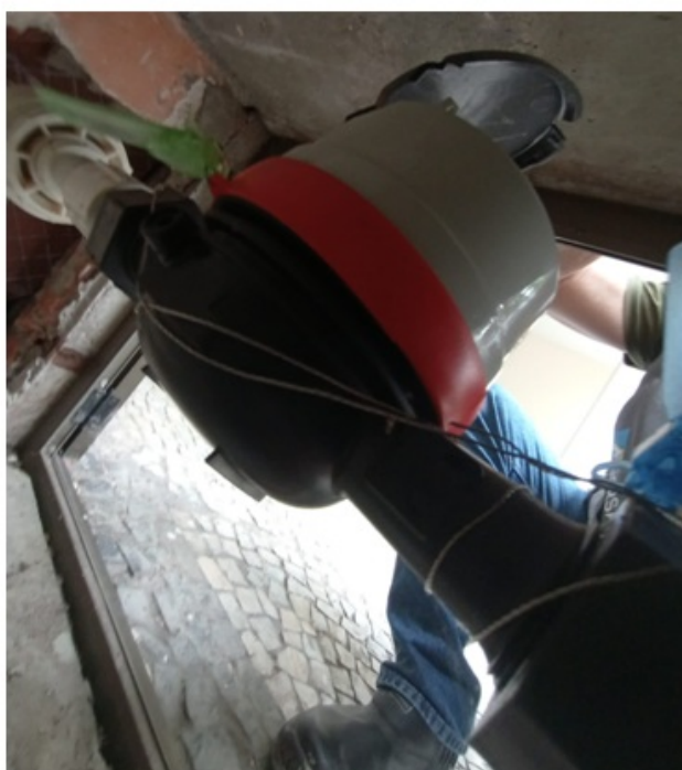
Foto 6 – Arame do selo de virola envolvendo os tubetes e o hidrômetro.
