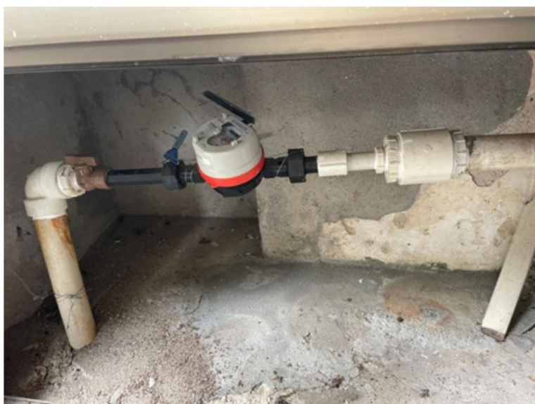
Foto 8 – Arame do selo de virola envolvendo o tubete, o hidrômetro e preso nas duas virolas.
