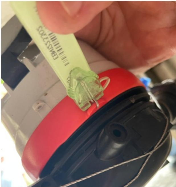
Foto 9 – Selo de relojoaria do hidrômetro sem violação.
