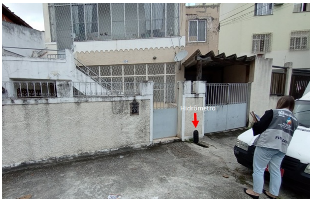
Foto 2 - Localização do hidrômetro no passeio público do imóvel.
