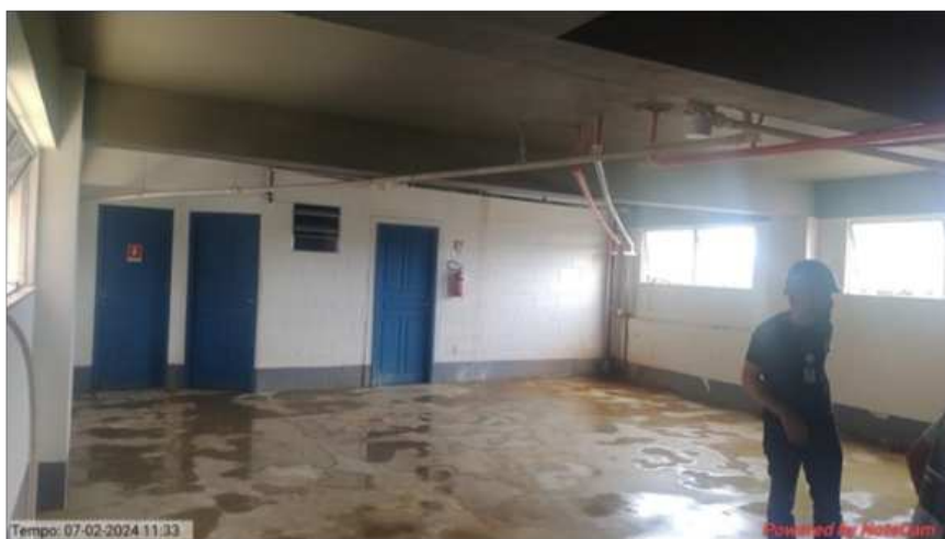
Foto 8 – 2º Pavimento prédio operacional
