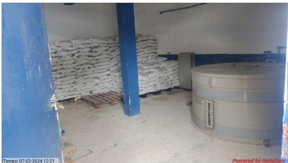
Foto 24 – Armazenamento do sal e tanque de de diluição (salmoura)
