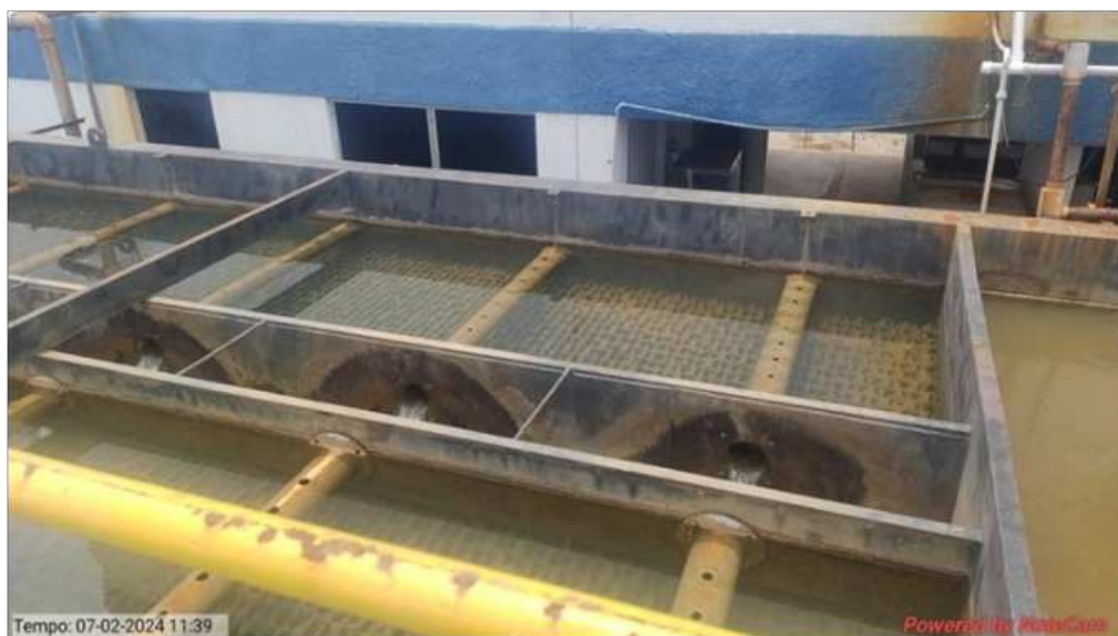
Foto 16 – Tanque de decantação ETA 1
