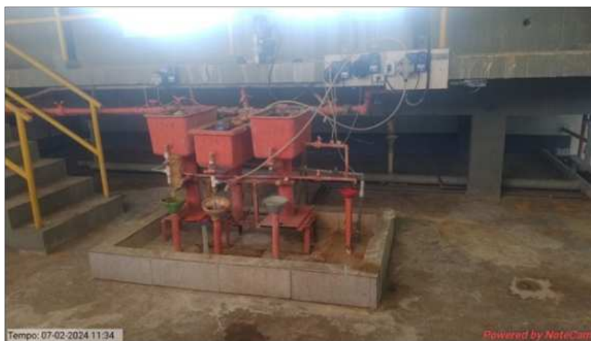
Foto 9 – Injeção de produtos químicos
