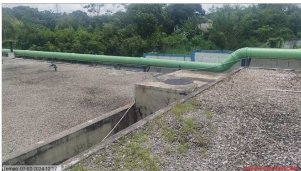
Foto 20 – Reservatório da ETA
