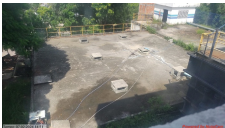
Foto 7 – ERES Marambaia ( Elevado)
