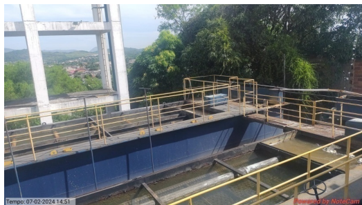
Foto 6 - Vista dos Floculadores e decantadores
