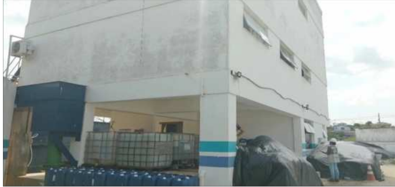
Foto 1 - Entrada da estação de tratamento.
