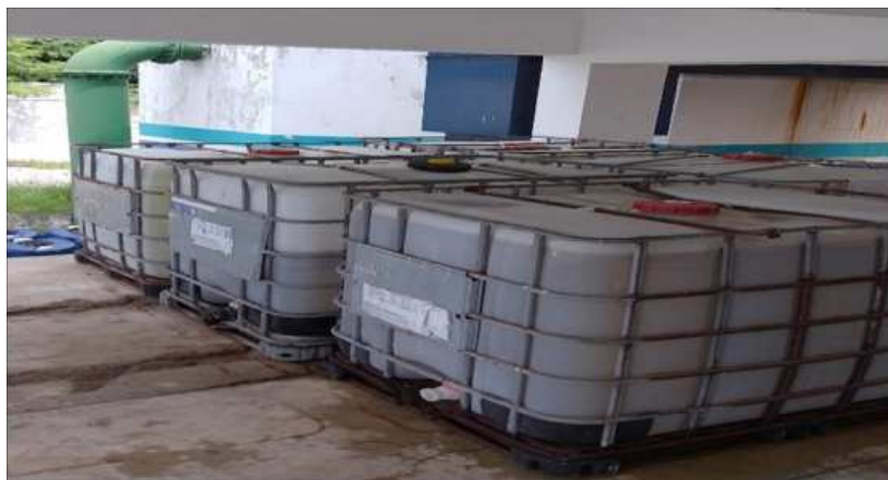
Foto 4 - Armazenagem de hipoclorito.
