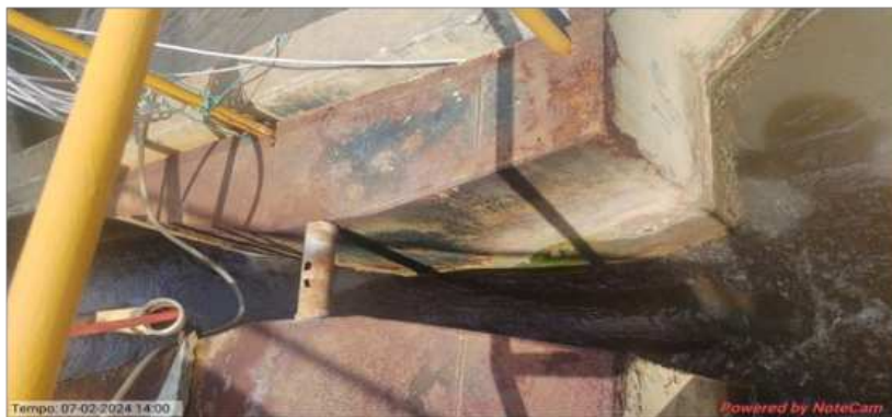
Foto 8 – Medidor de vazão tipo Calha Parshall
