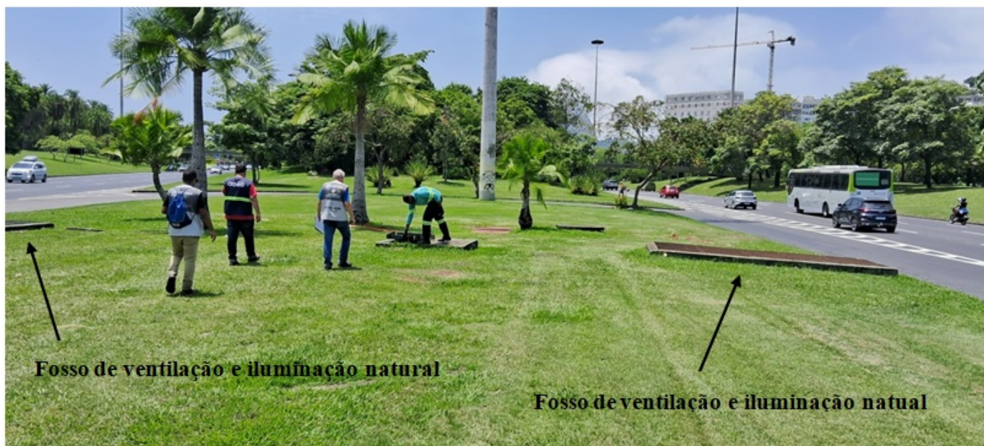
Foto 13 – Fosso de ventilação e iluminação natural.
