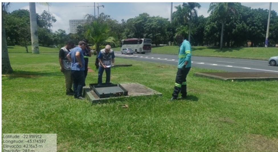
Foto 9 – Abrigo subterrâneo da motobomba e do painel de controle.
