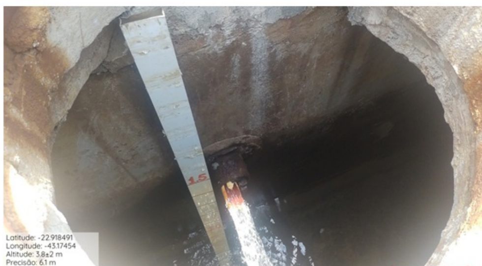
Foto 5 – Cisterna do Aterro sendo abastecida pela elevatória da Praça Paris.
