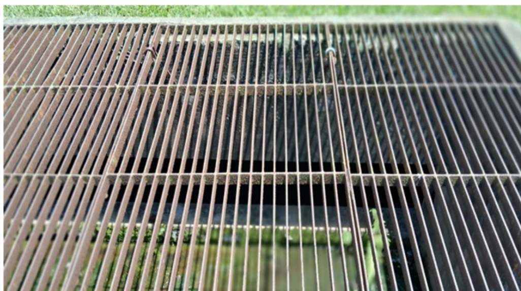
Foto 12 – Fosso de ventilação e iluminação natural.
