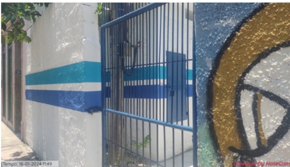
Foto 1 – Muro e portão de entrada da EEAT.
