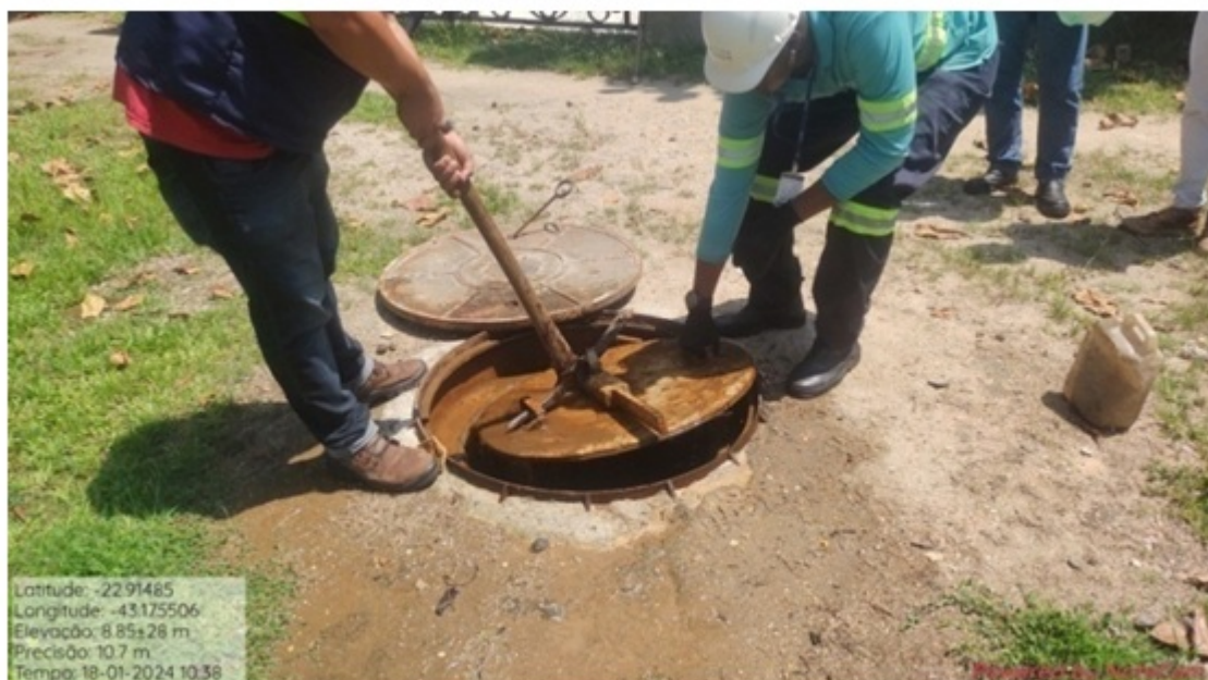
Foto 5 – Abrigo subterrâneo da motobomba sendo aberto
