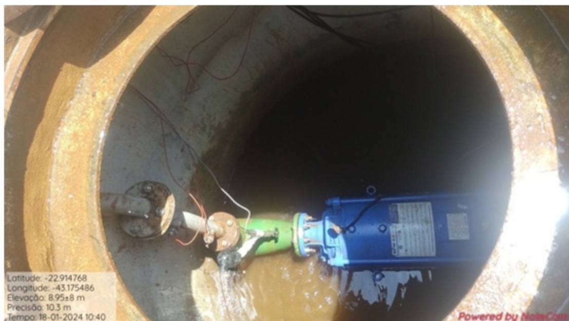
Foto 7 – Motobomba instalada no interior do abrigo subterrâneo e tubulação de recalque
