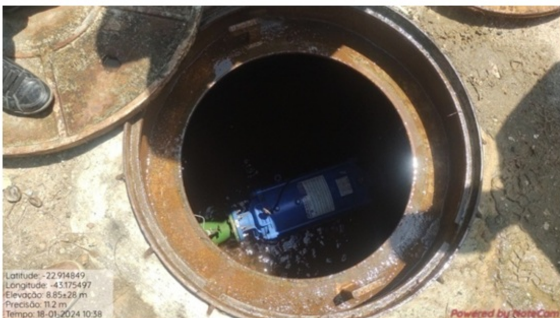
Foto 6 – Interior do abrigo subterrâneo da motobomba
