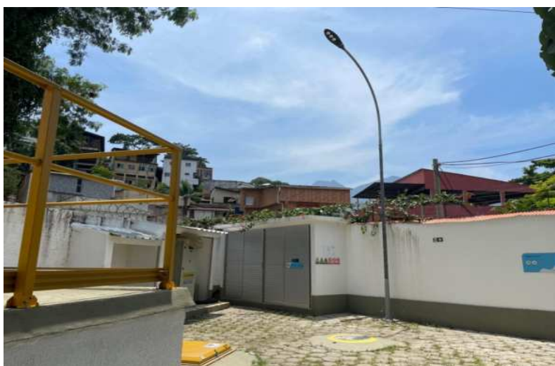
Figura 8 - Postes instalados dentro da elevatória para iluminação artificial.
