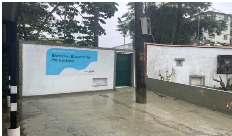
Figura 1 - Entrada da Estação Elevatória, devidamente identificada e restrita ao acesso de pessoas não autorizadas.
