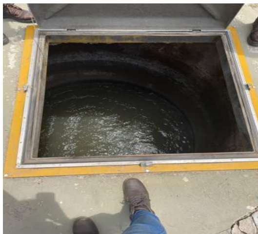
Figura 10 - Caixa de areia aberta e em conformidade.
