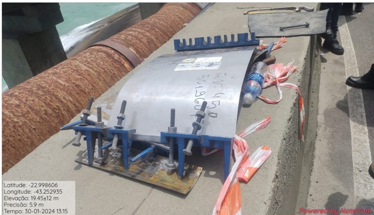
Foto 03 - Abraçadeira DN 450mm
