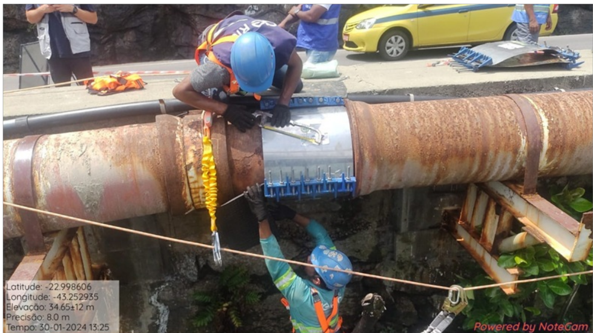
Foto 02 - Instalação da abraçadeira de reparo DN 500mm
