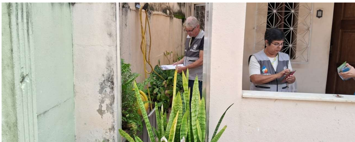
Foto 4 – Fachada frontal do imóvel nº 190 A, casa 1, mostrando a caixa do hidrômetro.
