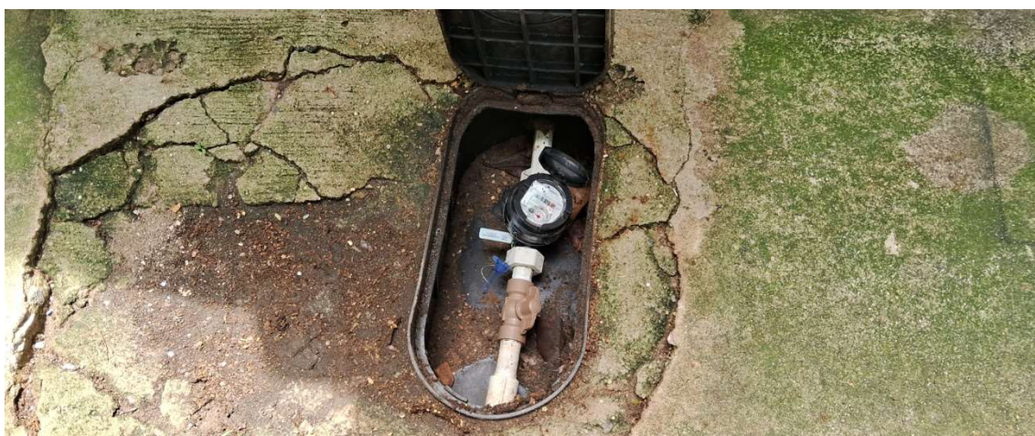
Foto 8 – Caixa de proteção do hidrômetro que foi instalado no passeio público.
