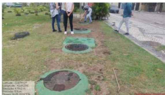
Foto 11: PVs da nova elevatória
