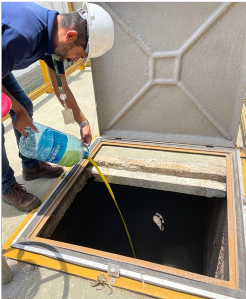
Figura 4 – Colaborador da concessionária despejando corante para verificação de vazamento da Elevatória.
