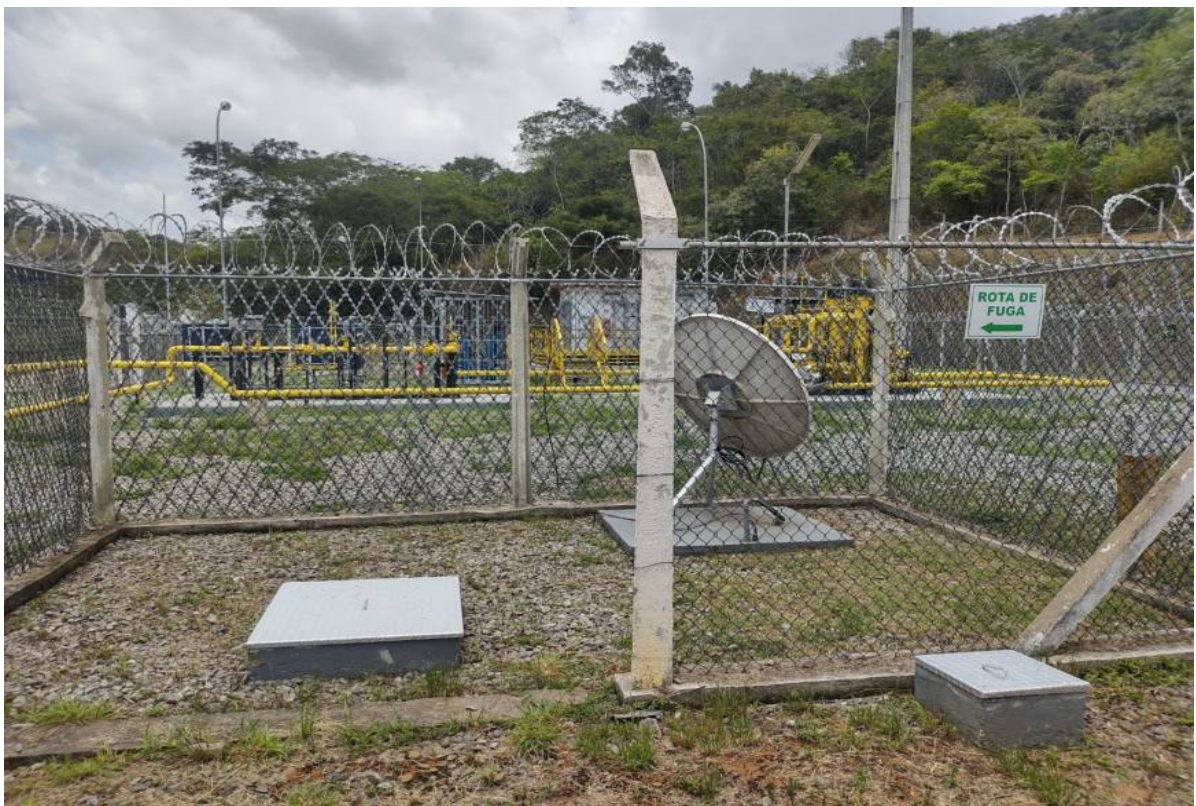
Foto 12: Sistema de transmissão de imagens – Antena parabólica.
