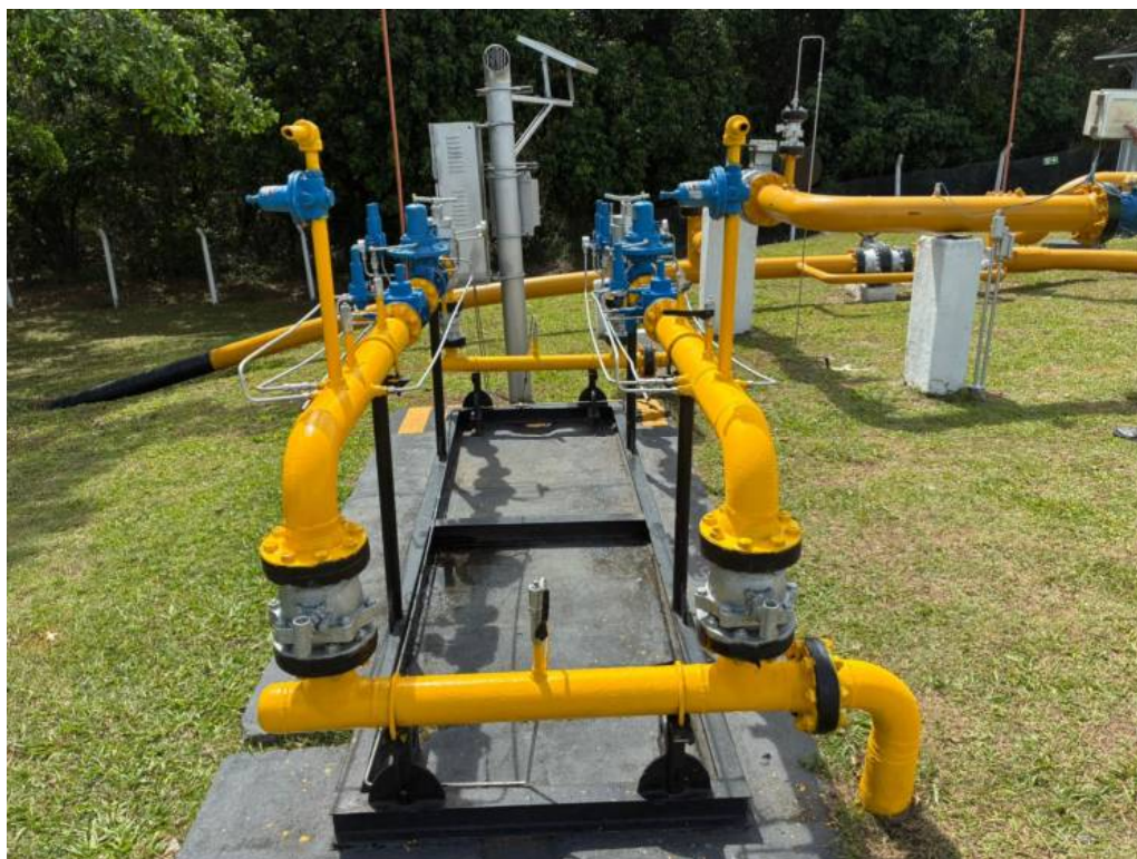
Foto 9: As duas linhas de regulagem da ERD.
