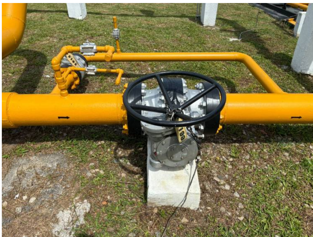
Foto 4: Válvula de bloqueio XV-02.
