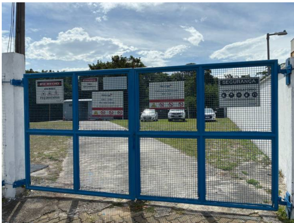
Foto 1: Entrada da estação com placas de identificação e de sinalização de segurança.
