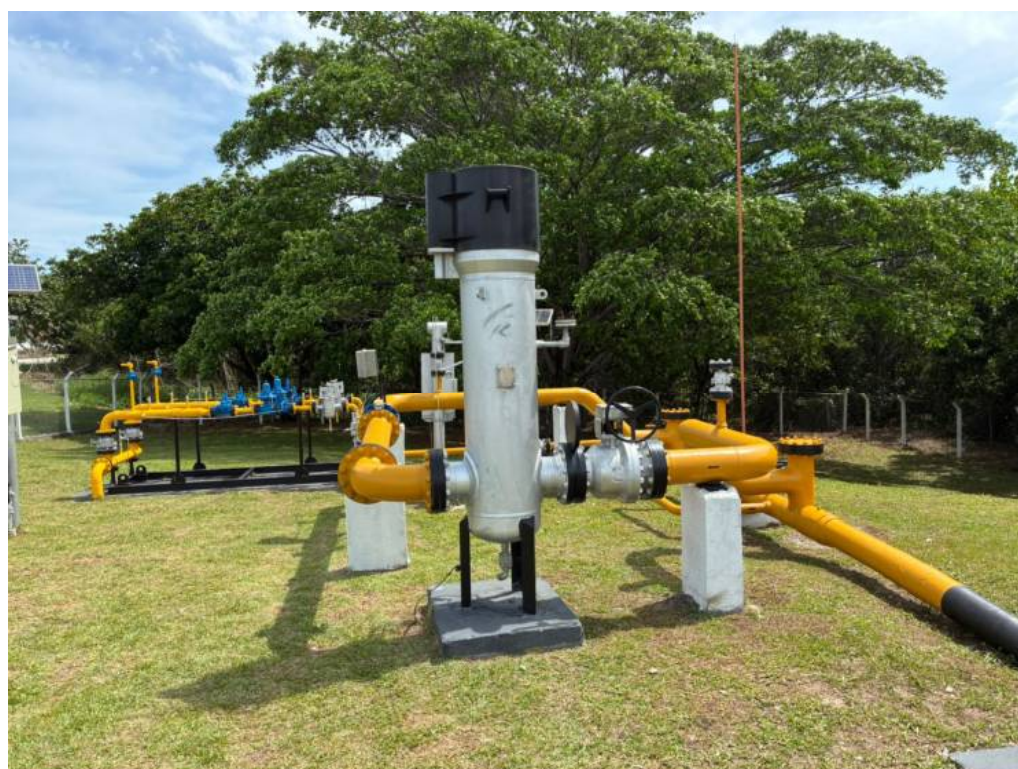
Foto 2: Vista geral da estação.
