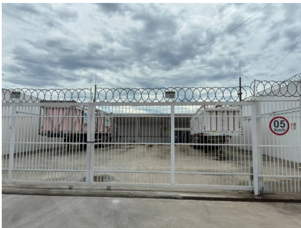
Foto 2: Vista externa da base de descompressão.
