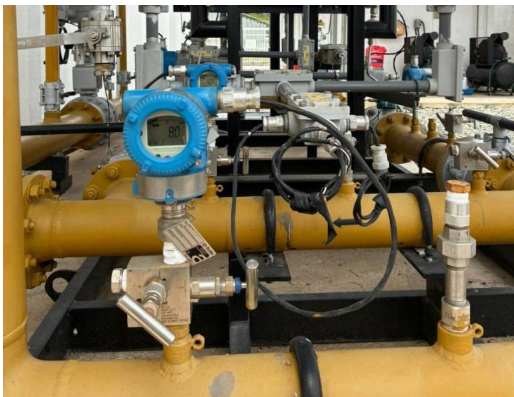
Foto 8: Medidor de pressão de entrada do gás na ERM.
