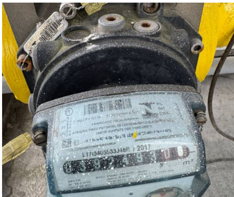
Foto 5: Medidor de gás individual dos geradores de energia.
