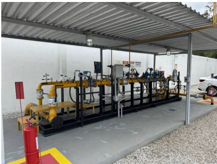
Foto 5: Skid de regulação da concessionária.
