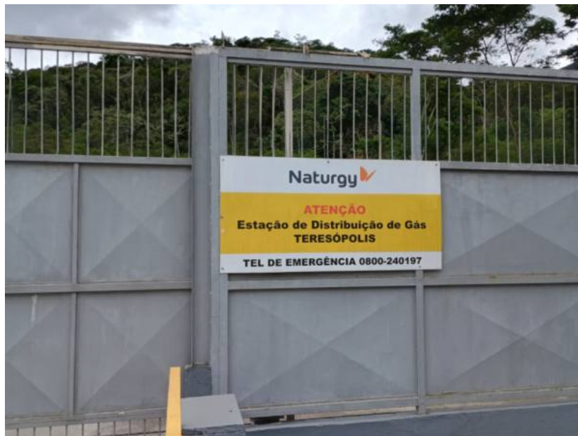
Foto 1: Placa de identificação da estação de descompressão de Teresópolis.
