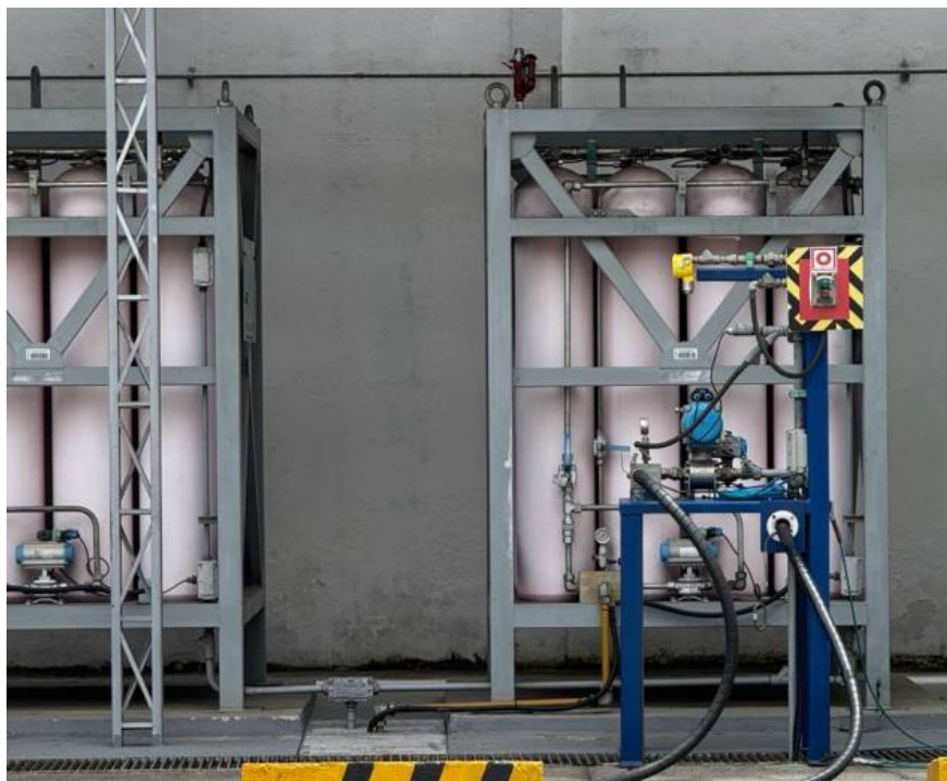
Foto 4: Estocagem com cilindros de GNC.
