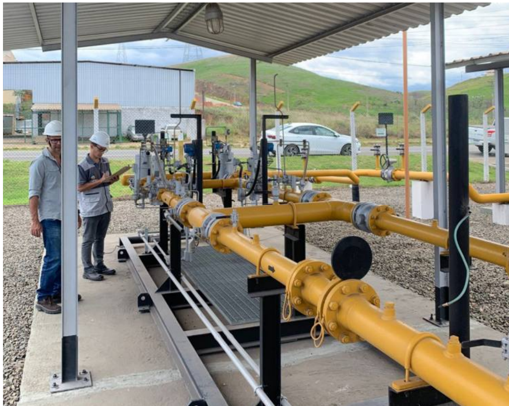
Foto 6: As duas linhas da ERM Itatiaia com seus reguladores e medidores.
