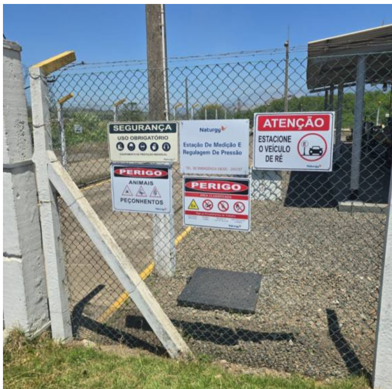
Foto 7: Placas de identificação e segurança substituídas (foto enviada pela Concessionária).
