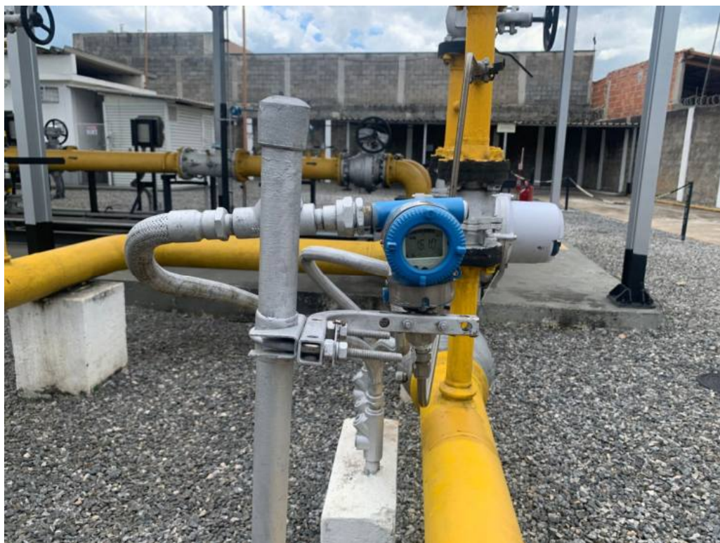
Foto 7: Medidor apontando pressão de saída do gás.
