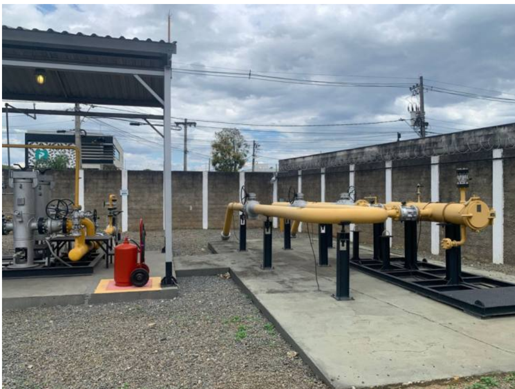
Foto 8: Canhão receptor de PIG de 8".
