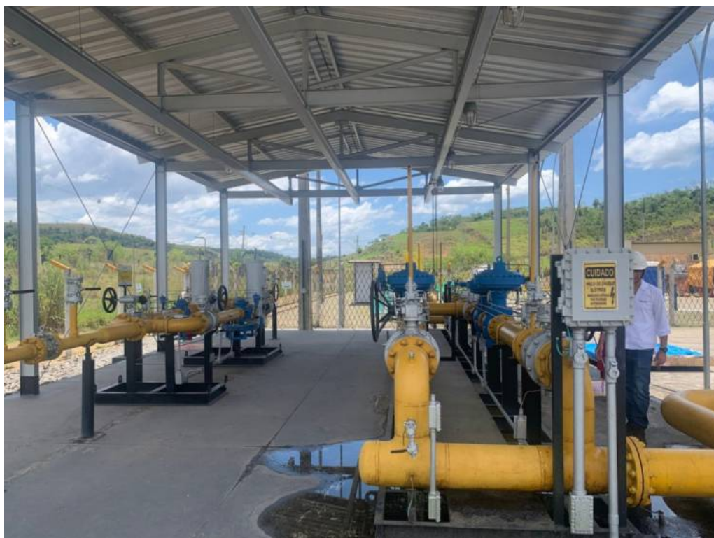
Foto 2: Vista da estação, com ERD à esquerda e ETC à direita.
